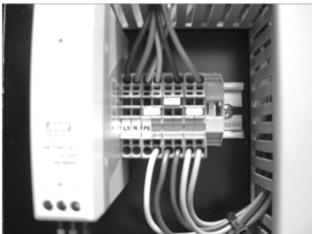
Abb. 3: Spannungsversorgung anschließen
