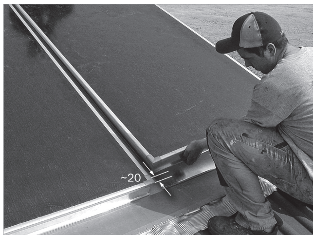
Fig. 53: applicare il prossimo collettore e spingerlo verso il basso contro la lamiera di supporto.
