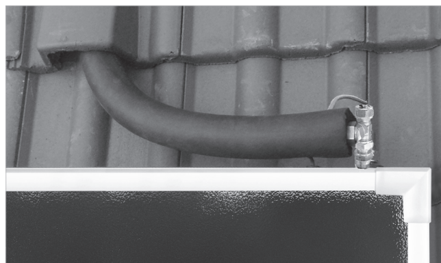
Fig. 93: Collegamento della mandata
