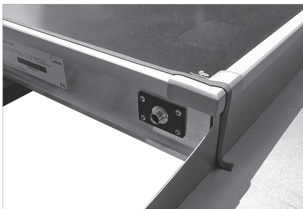
Fig. 78: incollare il nastro isolante di giunzione nel bordo superiore su tutta la larghezza
