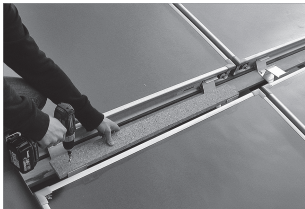
Fig. 67: avvvitamento dei sostegni per le lamiere intermedie sui distanziali dei collettori
