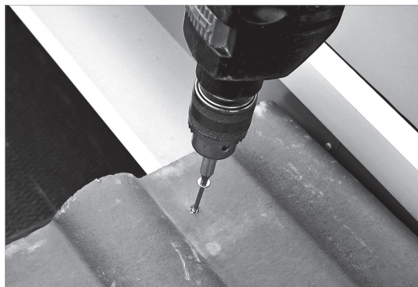
Fig. 87: fissare le tegole accanto alla lamiera laterale
