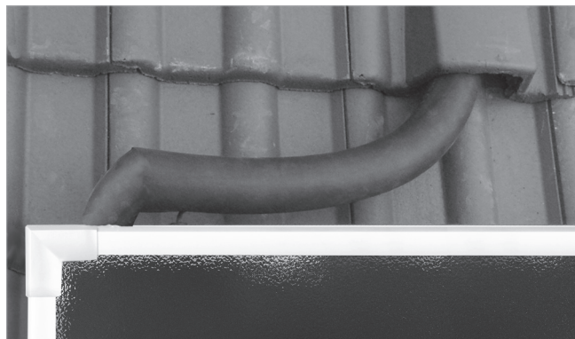
Fig. 92: Collegamento del ritorno
