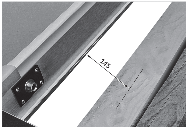
Fig. 59: per la fila successiva di collettori, montare all'occorrenza un ulteriore tavolato al di sopra del collettore.
