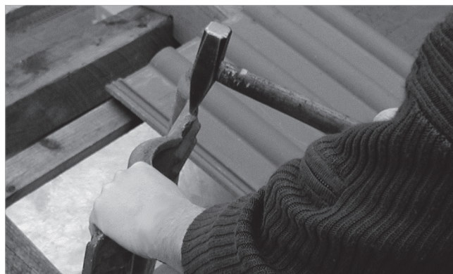
Fig. 86: eventuale rimozione dei naselli di supporto
