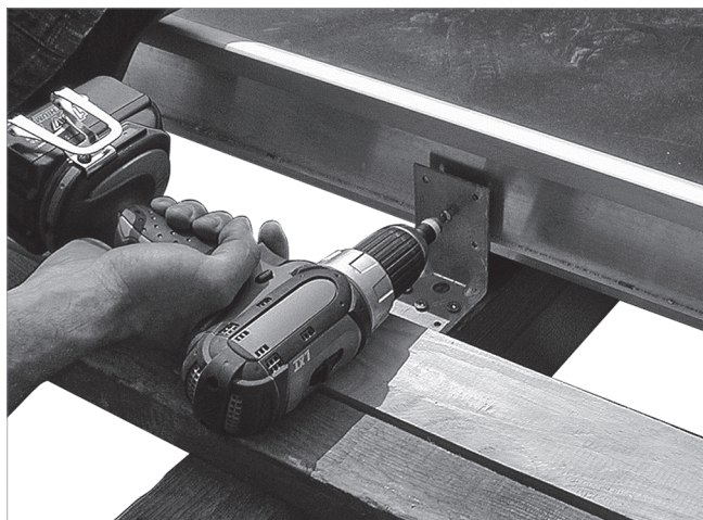
Fig. 50: nella parte frontale superiore, fissare il collettore al falso puntone
