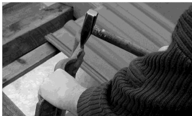
Fig. 86: eventuale rimozione dei naselli di supporto
