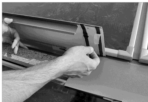
Fig. 74: montare ulteriori lamiere: prima dell'applicazione rimuovere la striscia di protezione
