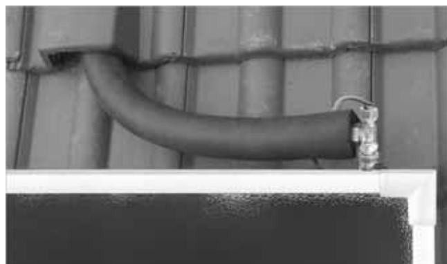
Fig. 93: Collegamento della mandata
