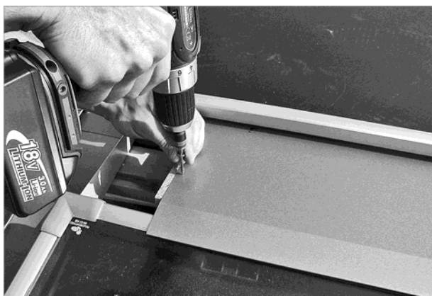
Fig. 71: avvitamento della lamiera intermedia a circa 10 mm dal bordo esterno sinistro
