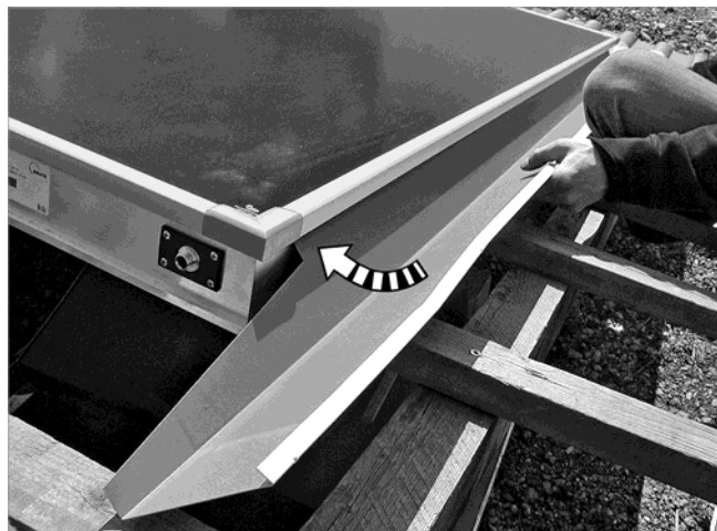
Fig. 55: posizionamento della lamiera nella scanalatura sotto il profilato a clip, montaggio successivo sul collettore
