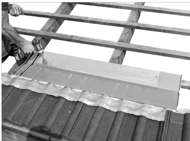
Fig. 46: montaggio e serraggio a destra della prima lamiera
