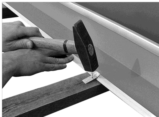
Fig. 58: fissaggio della lamiera ai correntini del tetto con chiodi e linguette
