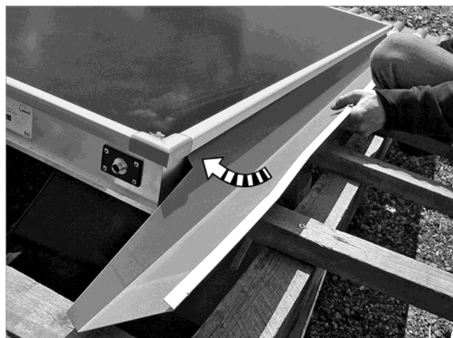
Fig. 63: posizionamento della lamiera nella scanalatura sotto il profilato a clip, montaggio successivo sul collettore
