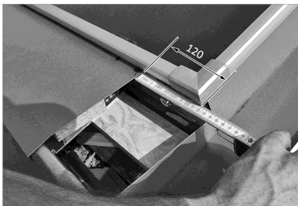
Fig. 70: portare la lamiera sulla distanza rispetto al bordo esterno
