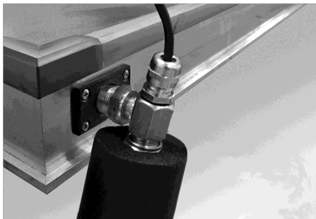
Fig. 91: Montaggio del sensore (mandata solare)
