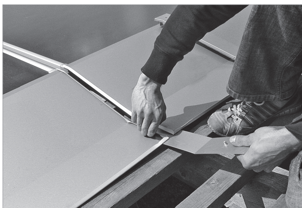
Fig. 80: Empujar la chapa inferior del conector de forma que se ajuste bajo la chapa superior
