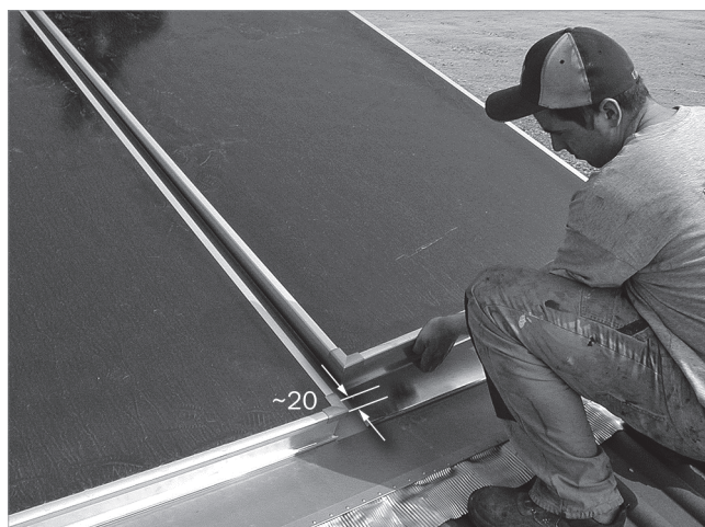
Fig. 53: Colocar el colector siguiente y empujar hacia abajo contra la chapa de sujeción
