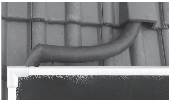
Fig. 92: Conectar el retorno
