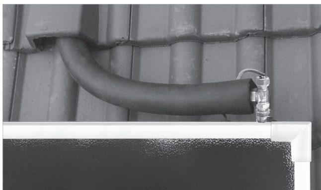
Fig. 93: Conectar el avance
