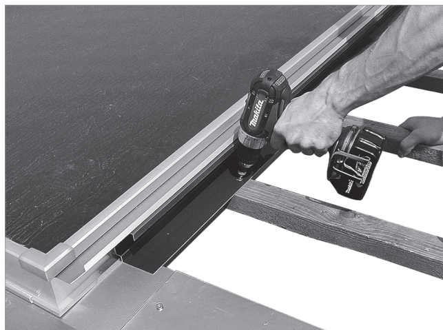
Fig. 52: Empujar hasta el tope hacia abajo y atornillar con las ripias
