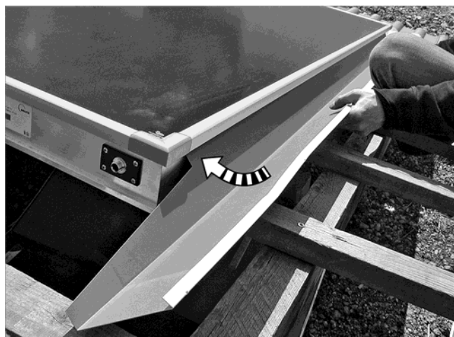
Fig. 55: Colocar la chapa en la ranura bajo el perfil de clip y después en el colector
