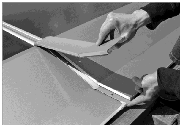
Fig. 81: Cubrir la chapa superior del conector con la chapa inferior
