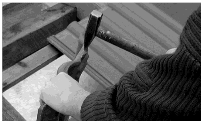
Fig. 86: Retirar las lengüetas de sujeción de ser necesario
