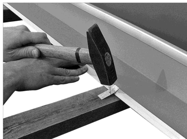
Fig. 58: Fijar las chapas con retenedor para chapa a las ripias
