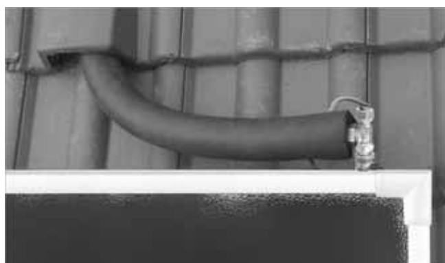
Fig. 93: Conectar el avance
