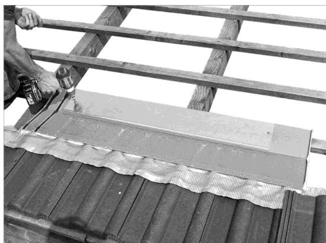
Fig. 46: Colocar la primera chapa por la derecha y atornillarla
