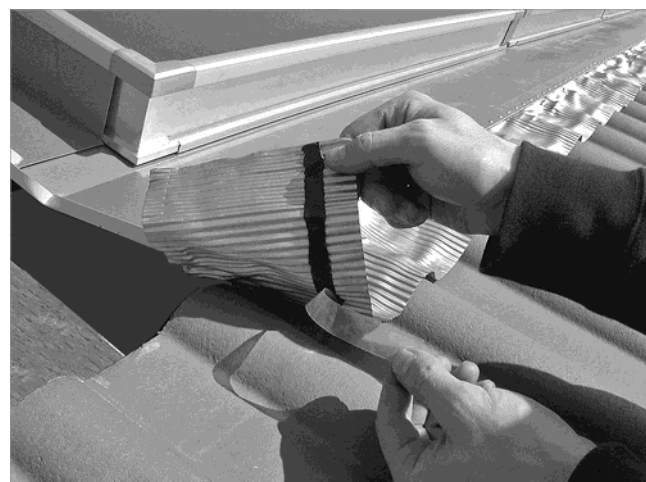
Fig. 48: Retirar las bandas protectoras y presionar las chapas de plomo
