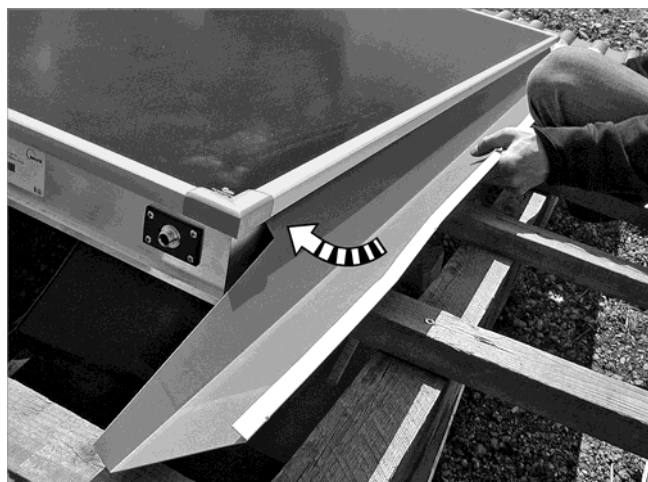
Fig. 63: Colocar la chapa en la ranura bajo el perfil de clip y después en el colector
