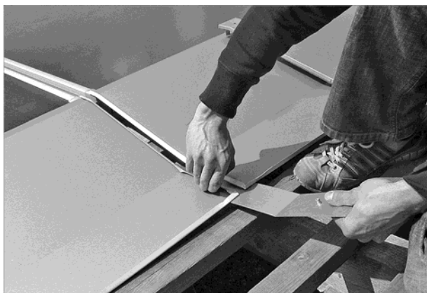
Fig. 80: Empujar la chapa inferior del conector de forma que se ajuste bajo la chapa superior
