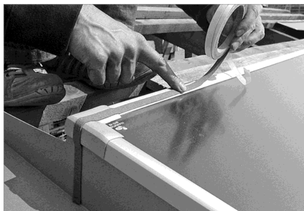
Fig. 68: Pegar la banda de estanqueidad al borde superior en toda su anchura
