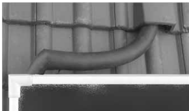
Fig. 92: Conectar el retorno
