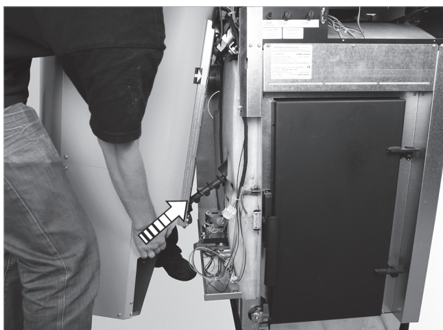
Abb. 56: Schneckenrohr einfädeln
