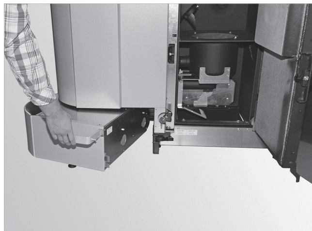
Abb. 102: Aschebehälter einschieben (LI-4-xx-GS)
