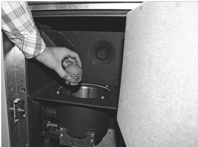
Abb. 148: Primärluftdorn entnehmen
