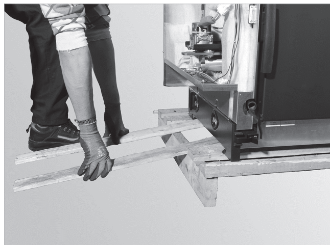
Abb. 7: Verschlagbretter an Rampe legen
