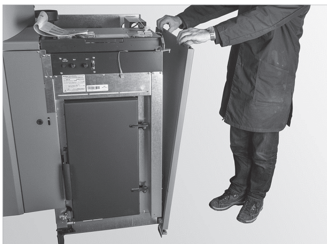
Abb. 88: Seitenwand einhängen
