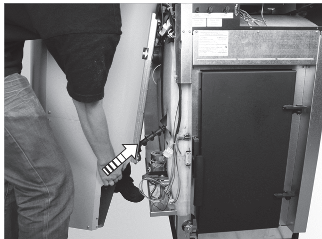
Abb. 28: Förderschnecke einfädeln
