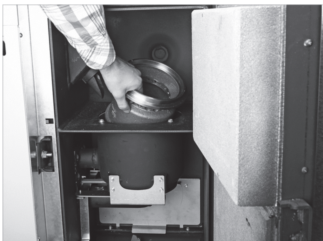
Abb. 144: Konus Unterteil herausheben
