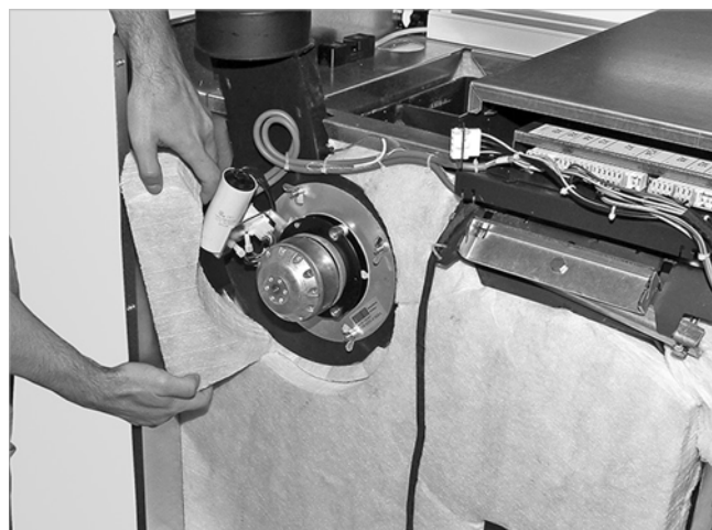
Abb. 21: Isolierung um Abgasgebläse entfernen
