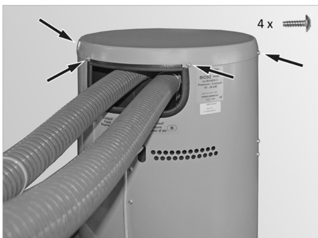
Abb. 106: Montage Förder- und Rückluftschlauch
