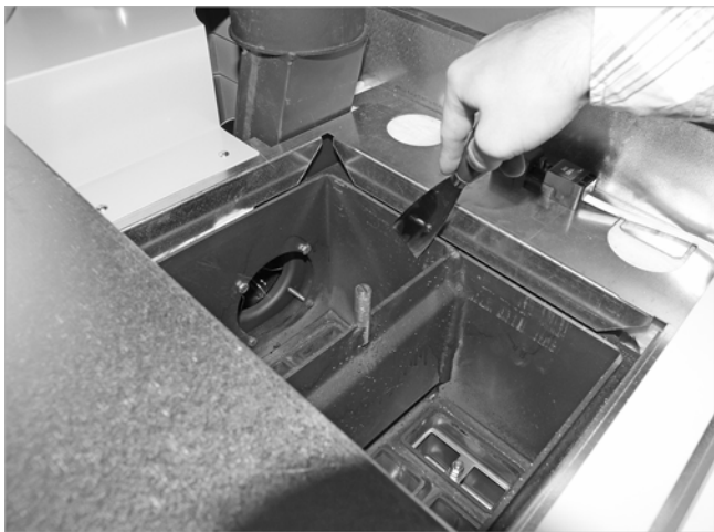
Abb. 159: Nachheizflächen reinigen
