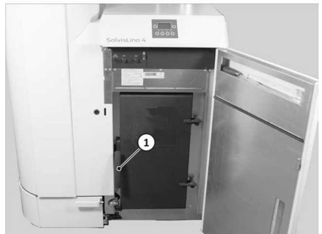
Abb. 125: Hebel (1) nach oben ziehen
