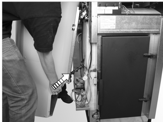
Abb. 28: Förderschnecke einfädeln
