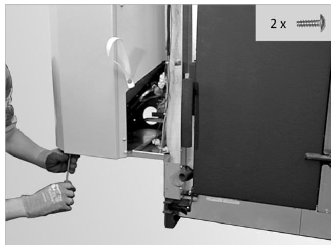
Abb. 39: Blende befestigen
