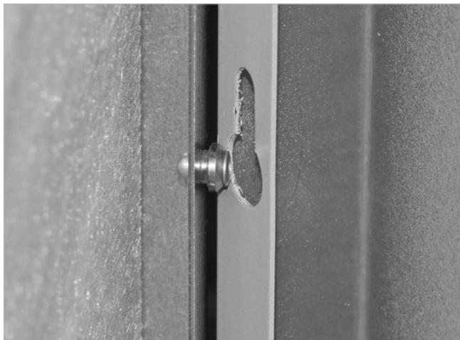
Abb. 87: Bajonettverschluss
