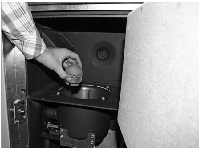
Abb. 148: Primärluftdorn entnehmen
