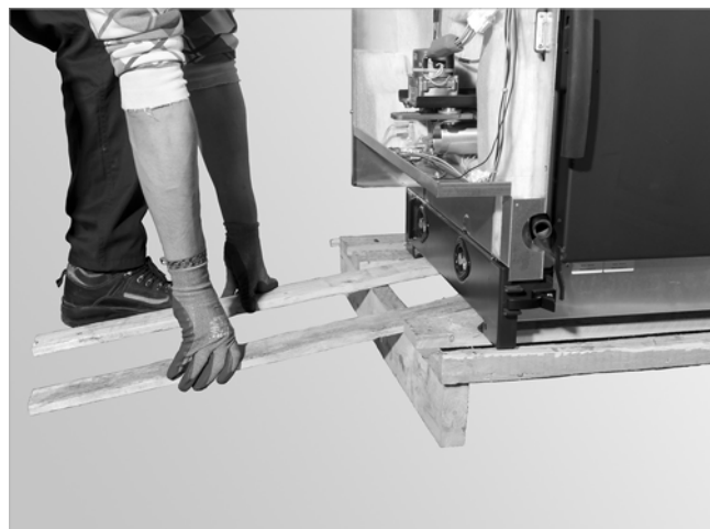
Abb. 7: Verschlagbretter an Rampe legen
