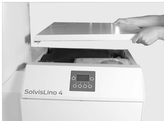
Abb. 128: Verkleidungsdeckel nach hinten abnehmen
