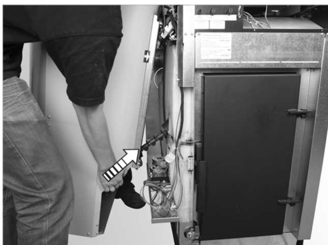
Abb. 56: Schneckenrohr einfädeln
