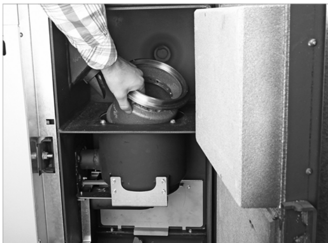
Abb. 144: Konus Unterteil herausheben
