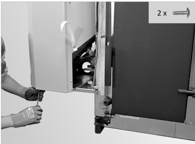
Abb. 167: Schrauben unten entfernen
