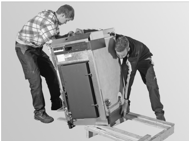
Abb. 9: Kessel von Palette schieben
