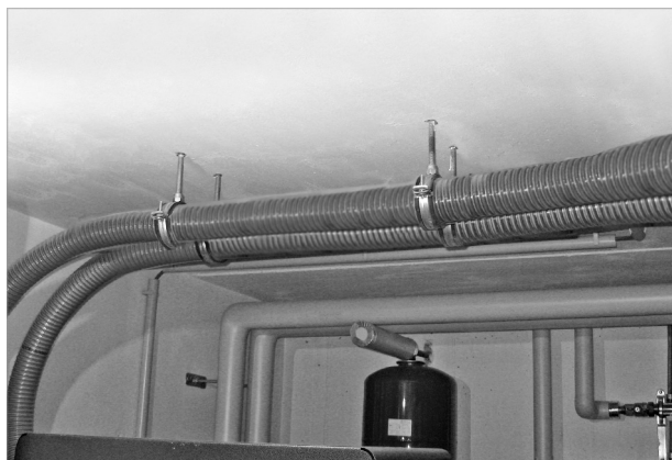
Abb. 26: Förderschläuche befestigen
