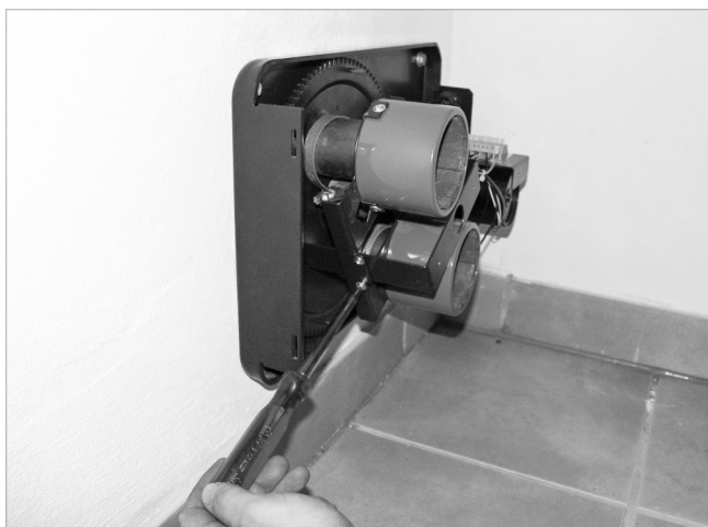
Abb. 28: Schläuche mit Schlauchklemmen befestigen
