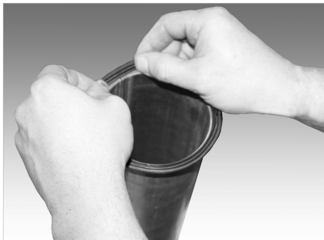
Abb. 64: Dichtring aufziehen
