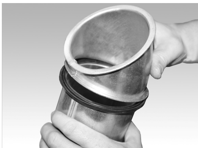
Abb. 65: Rohrstücke zusammenhalten
