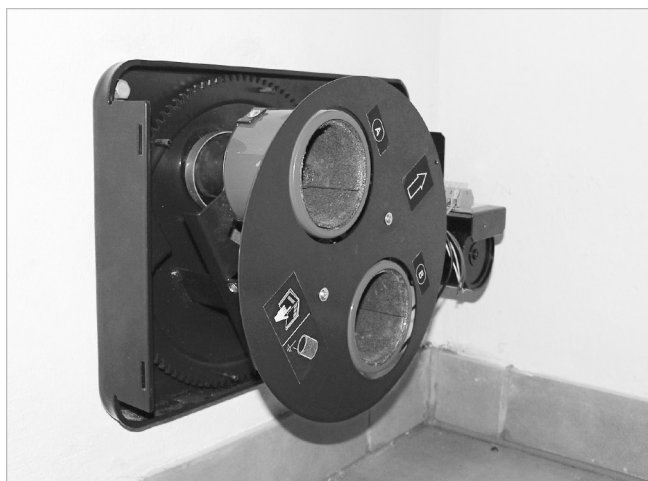
Abb. 25: Abdeckscheibe montieren
