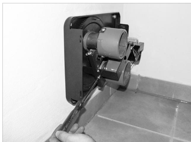
Abb. 24: Brandschutzmanschetten montieren
