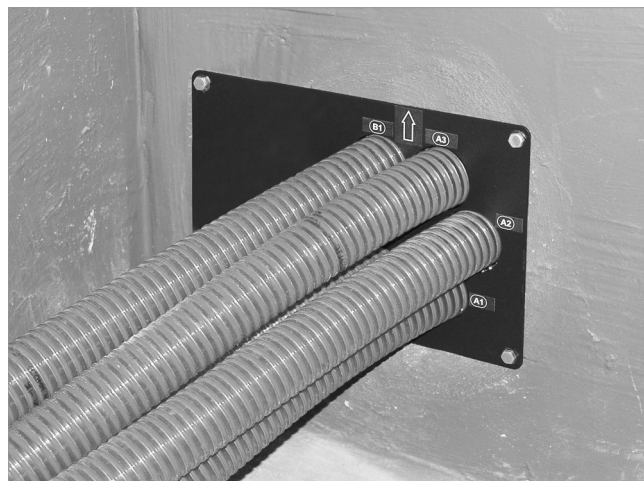
Abb. 14: Abdeckblech mit Schlauchenden eingesteckt
