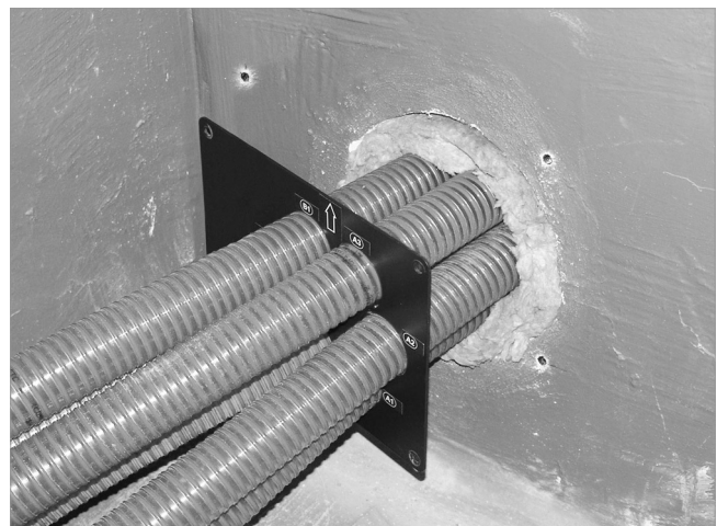
Abb. 19: Mauerdurchführung mit Steinwolle ausstopfen
