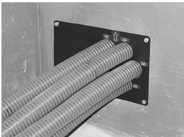
Abb. 20: Abdeckblech montieren
