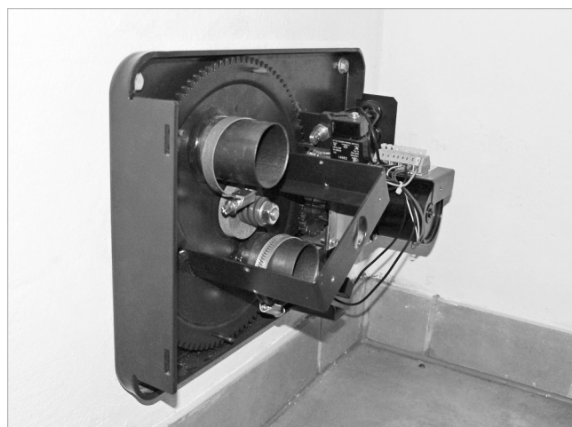
Abb. 23: Schlauchklemmen aufstecken
