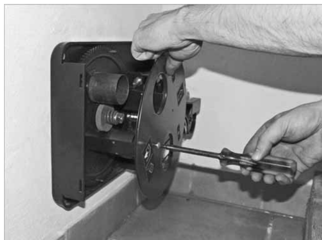
Abb. 22: Abdeckscheibe abschrauben
