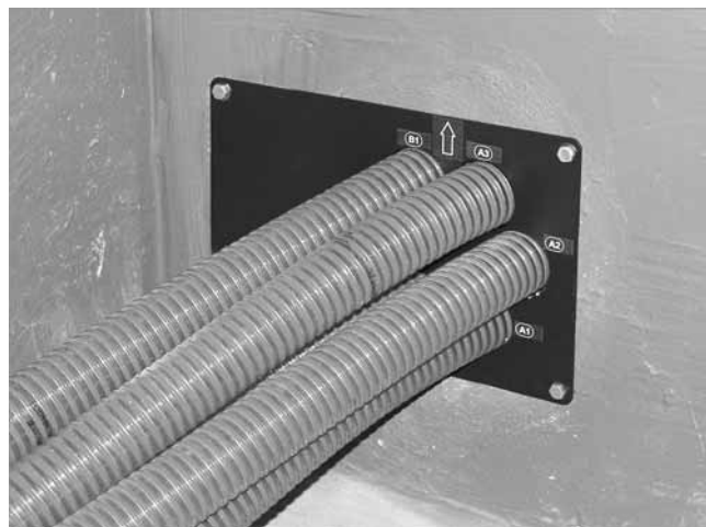
Abb. 14: Abdeckblech mit Schlauchenden eingesteckt
