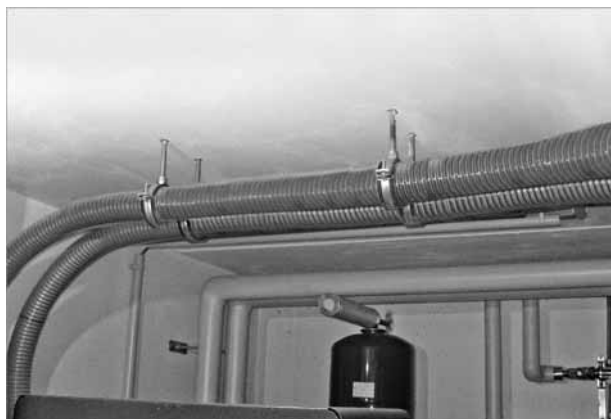
Abb. 26: Förderschläuche befestigen
