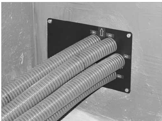
Abb. 20: Abdeckblech montieren
