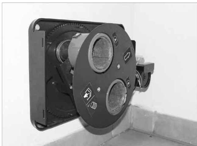
Abb. 25: Abdeckscheibe montieren
