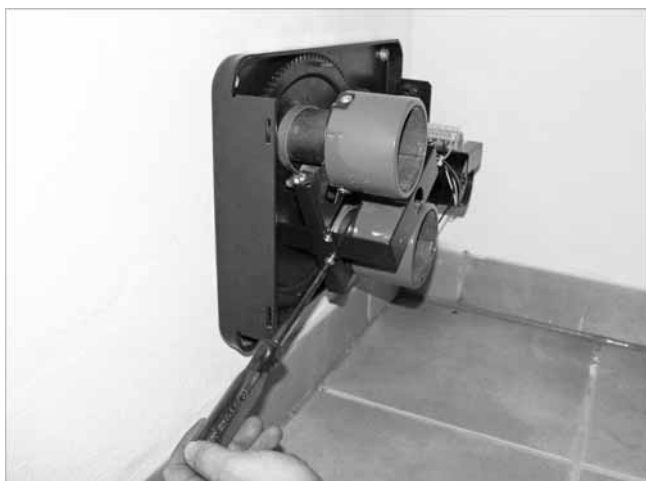
Abb. 28: Schläuche mit Schlauchklemmen befestigen
