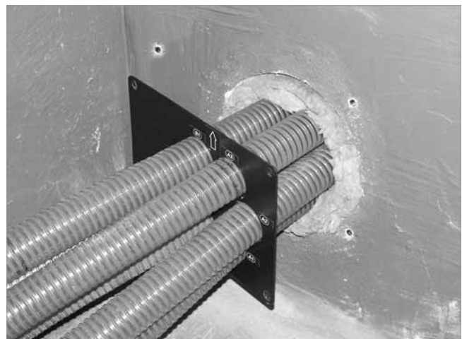
Abb. 19: Mauerdurchführung mit Steinwolle ausstopfen
