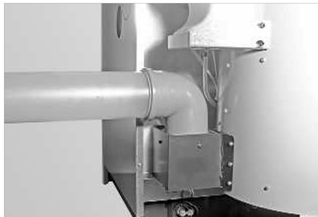
Abb. 10: Zuluftrohr montieren
