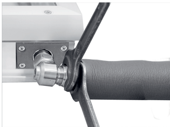
Abb. 62: Anschluss unten: Solar-Vorlauf
