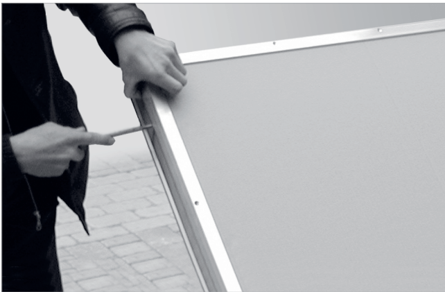
Abb. 32: Clip-Profil und Abdeckpappen entfernen
