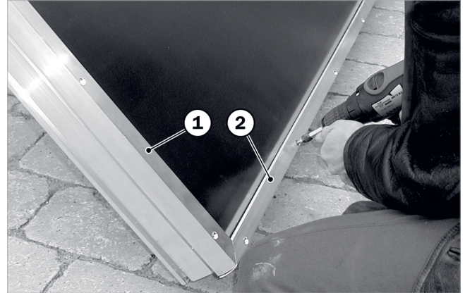
Abb. 34: Clip-Profil auflegen, ausrichten, verschrauben
