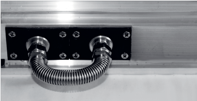
Abb. 54: Anschlussbogen montiert
