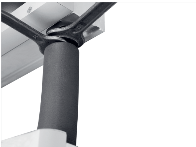
Abb. 69: VB-F-S-D-UE am oberen Anschluss verschrauben
