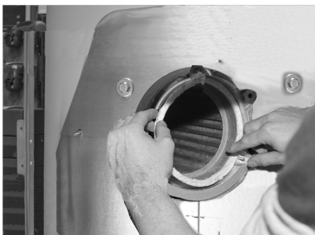
Abb. 6: Brennerdichtschnur einlegen, Stoß oben
