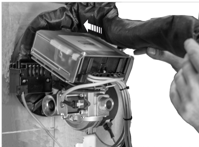
Abb. 9: Mulde am Brennerflansch ausstopfen
