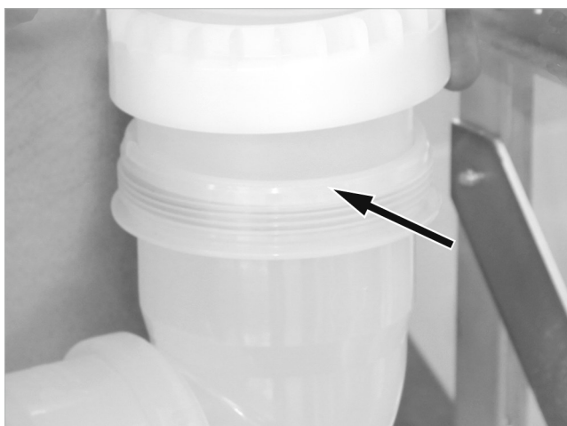
Abb. 19: Abgasbogen gerade ausgerichtet verschrauben
