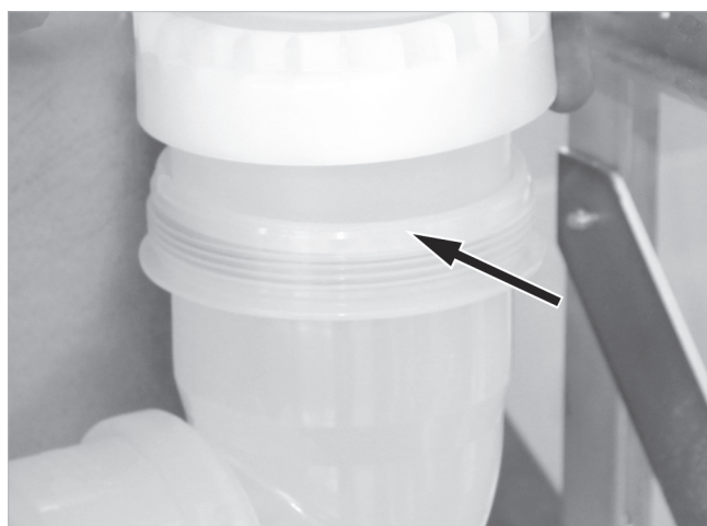
Fig. 15 : vissage du coude d'évacuation des gaz à la verticale
