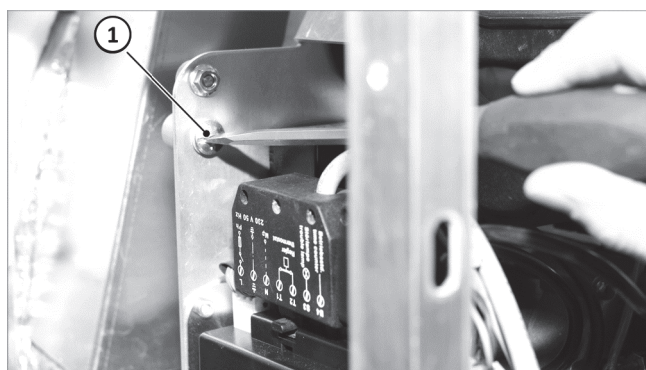
Fig. 31 : vis de fermeture rapide sur le brûleur
