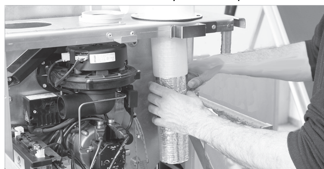
Fig.11 : installation du silencieux du tuyau interne
