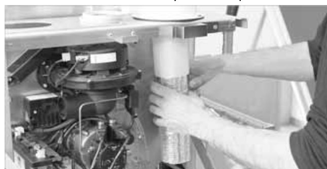
Fig.11 : installation du silencieux du tuyau interne
