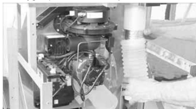
Fig.12 : mise en place du raccord d'évacuation des gaz
