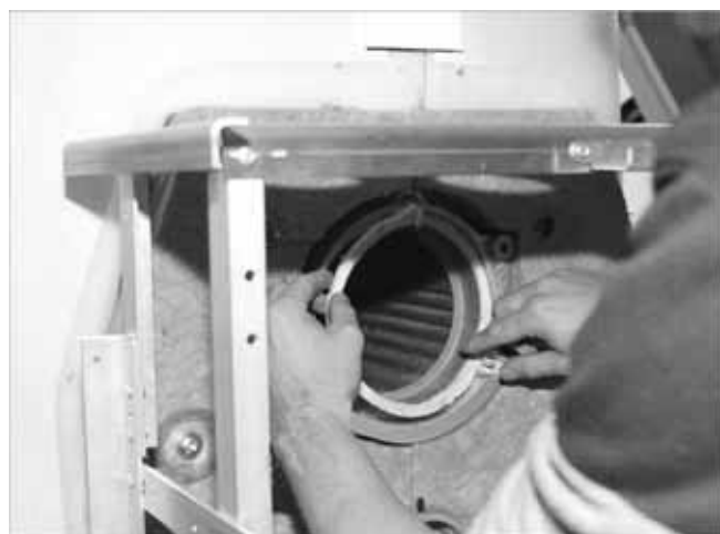
Fig. 1 : installation du cordon d'étanchéité
