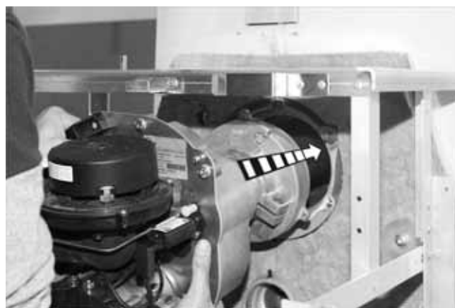
Fig. 7 : montage du brûleur
