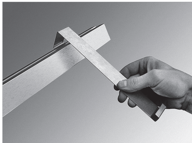
Fig. 20 : accrochage de la protection contre les chutes (2 par capteur)
