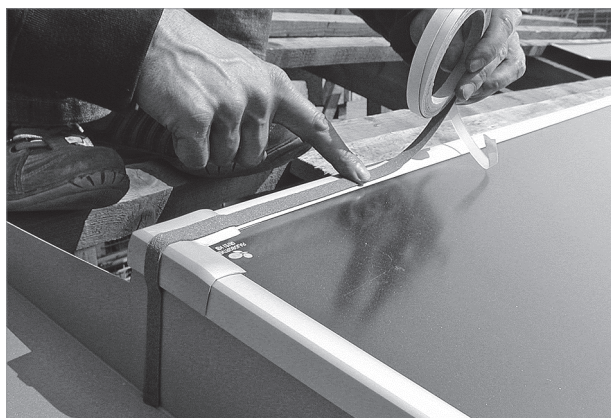
Fig. 68 : Collage d'une bande d'étanchéification sur toute la largeur de la bordure supérieure
