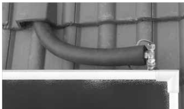
Fig. 93 : raccord de l'aller
