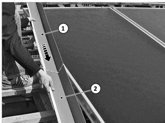
Fig. 62 : pousser la tôle latérale sur la partie inférieure
