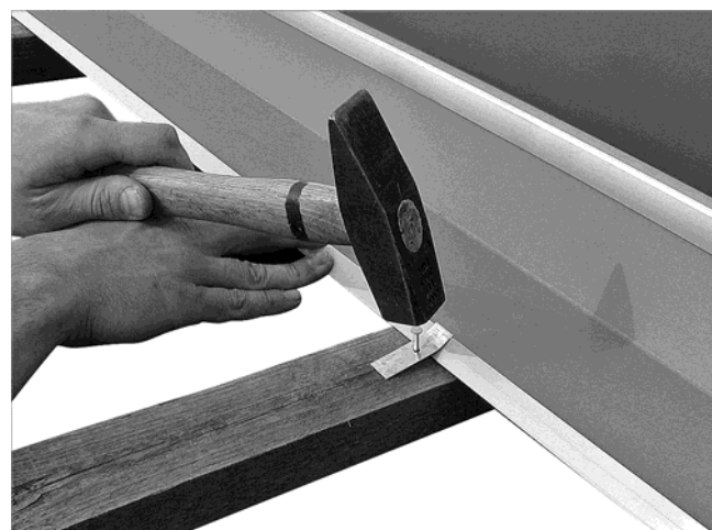
Fig. 66 : fixation aux liteaux à l'aide de serre-flancs
