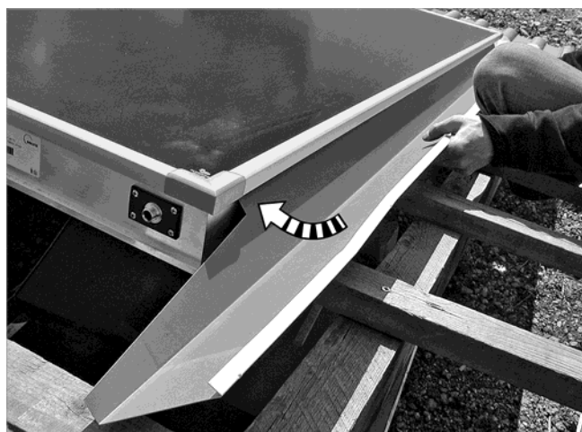
Fig. 63 : Pose de la tôle sur la rainure située sous le profil à clip puis sur le capteur
