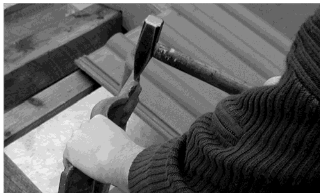
Fig. 86 : le cas échéant, retirer les crochets de fixation
