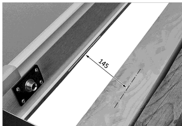
Fig. 59 : le cas échéant, pour une rangée de capteurs supplémentaire : poser la volige supplémentaire au-dessus du capteur
