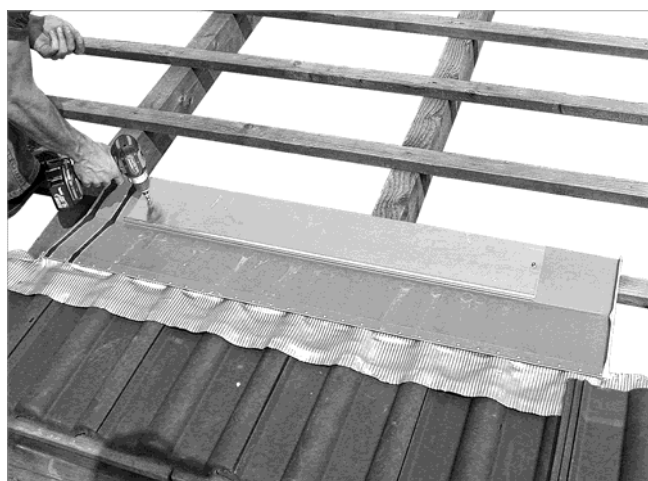
Fig. 46 : pose de la première plaque à droite et vissage
