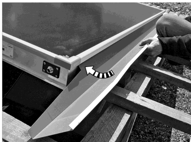
Fig. 55 : Pose de la tôle sur la rainure située sous le profil à clip puis sur le capteur
