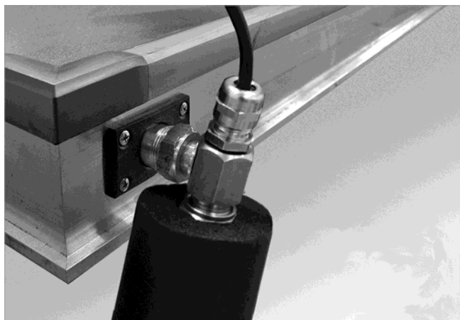
Fig. 91 : Monter le capteur (aller solaire)
