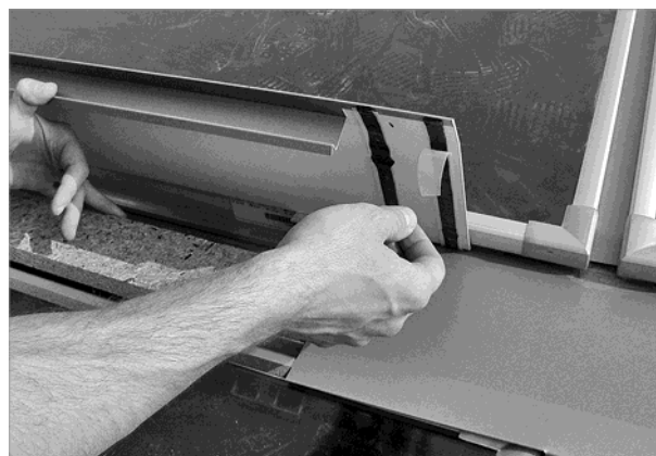
Fig. 74 : Montage d'autres tôles : retrait des bandes de protection avant la pose
