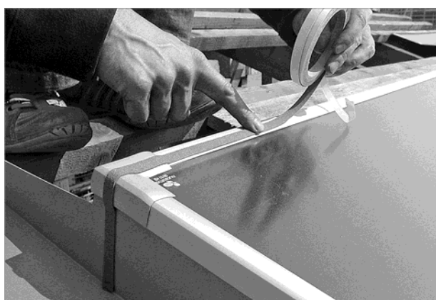
Fig. 68 : Collage d'une bande d'étanchéification sur toute la largeur de la bordure supérieure
