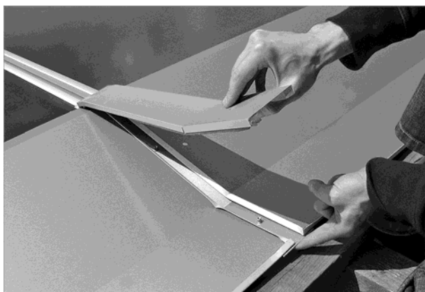
Fig. 81 : recouvrir la tôle supérieure avec la plaque inférieure
