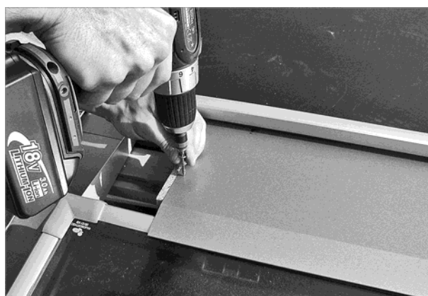
Fig. 71 : vissage de la tôle intermédiaire à environ 10 mm du bord extérieur gauche
