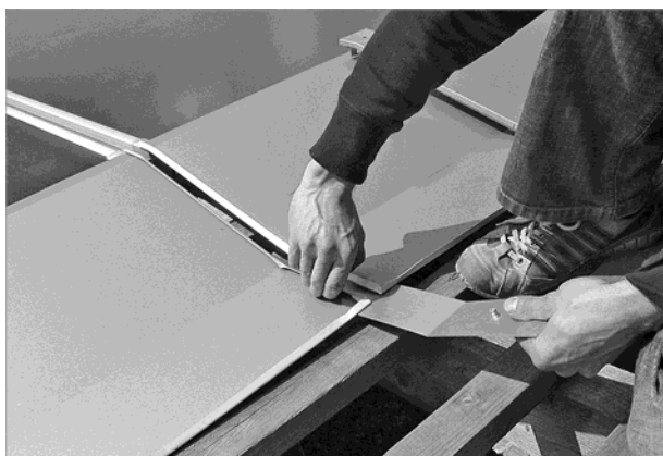
Fig. 80 : Pousser la tôle inférieure du raccord en dessous de la tôle supérieure
