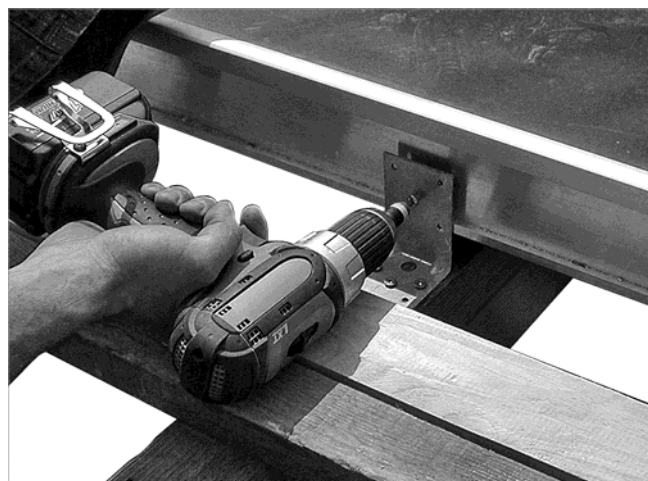
Fig. 50 : fixation du capteur sur le chevron au niveau de la face supérieure avant
