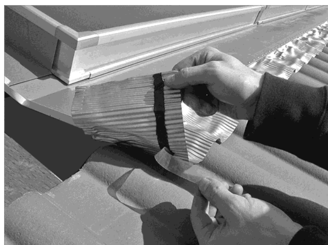
Fig. 48 : Retrait des bandes de protection et application par pression des tabliers en plomb
