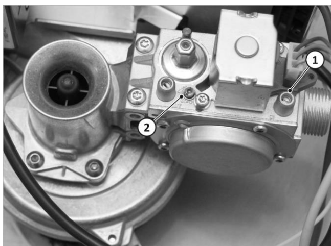
Fig. 30: impostazione del bruciatore
