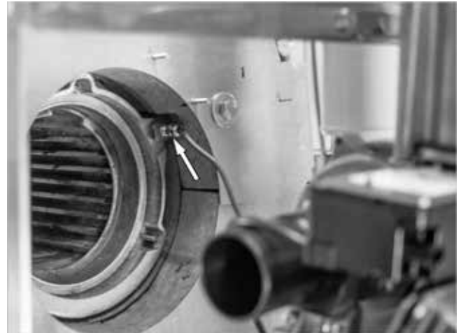
Fig. 7: inserimento dell'eSTB
