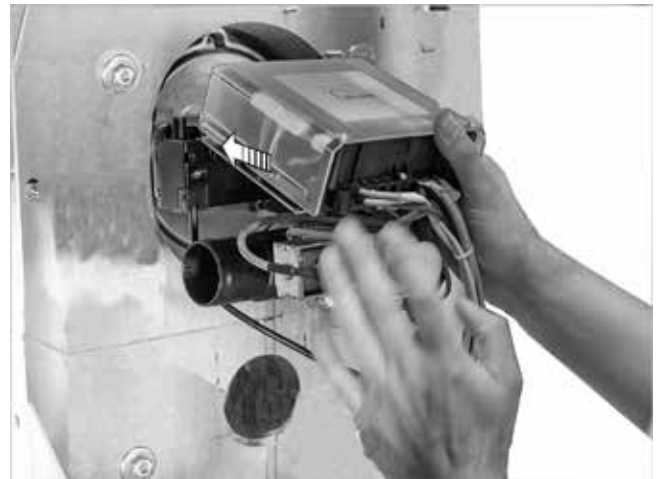
Fig. 8: Montaggio del bruciatore
