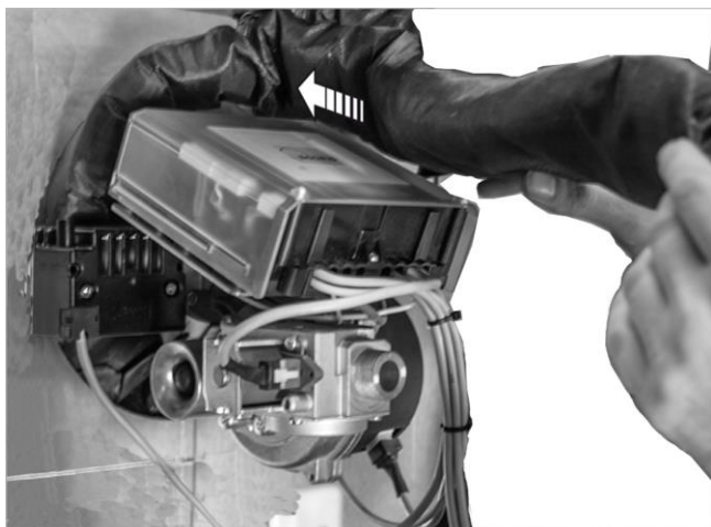
Fig. 9: Encajar en el espacio de la brida del quemador
