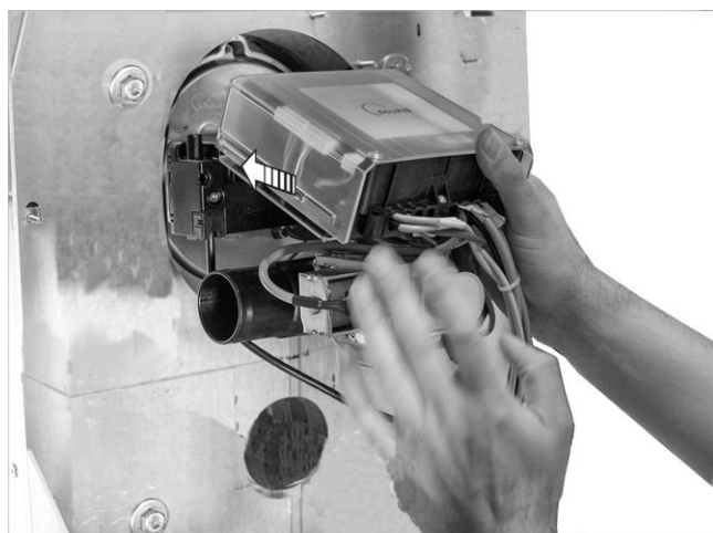
Fig. 8: Instalación del quemador
