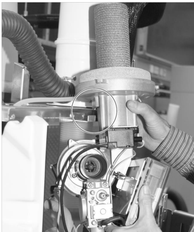
Fig. 31: Quemador en posición de mantenimiento en la consola
