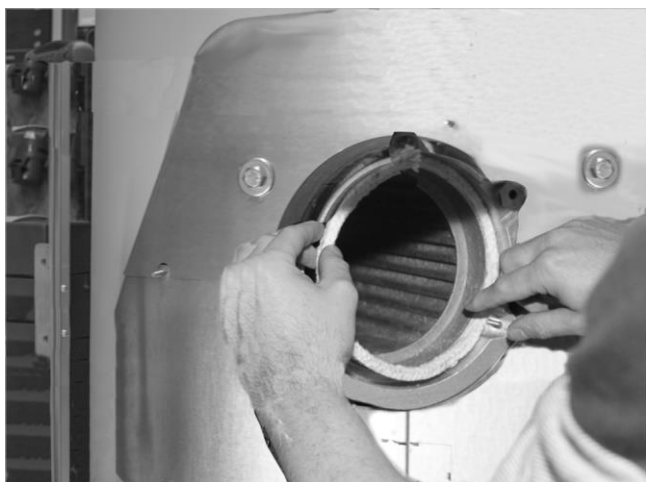
Fig. 6: Colocar el cordón de cierre hermético, extremo arriba
