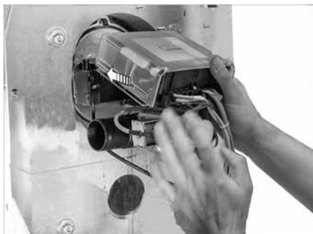
Fig. 8: Instalación del quemador
