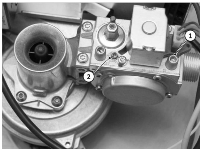
Fig. 30 : Réglage du brûleur
