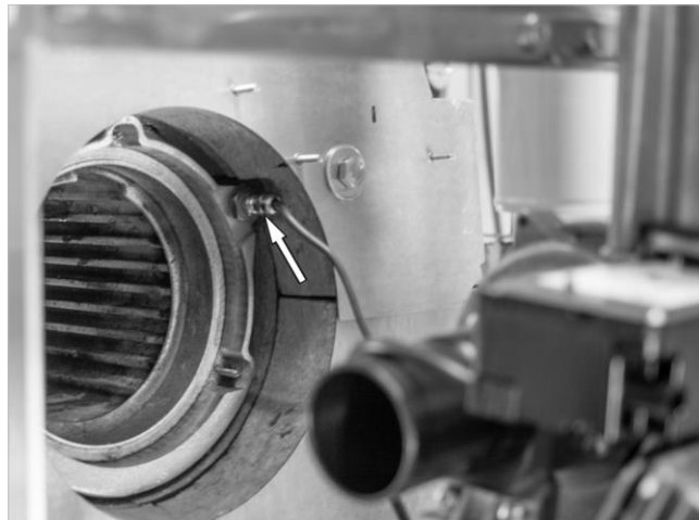
Fig. 7 : insertion de l'eSTB
