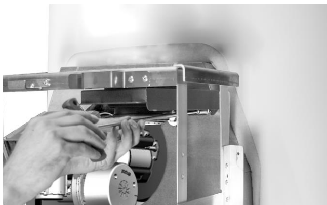
Fig. 14 : visser le support du soufflet d'étanchéité
