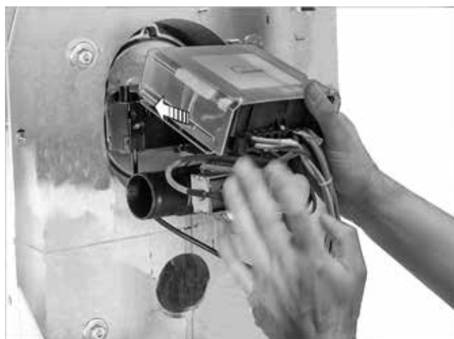
Fig. 8 : montage du brûleur
