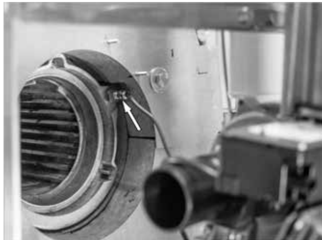
Fig. 7 : insertion de l'eSTB
