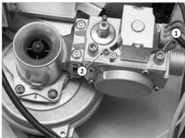
Fig. 30 : Réglage du brûleur
