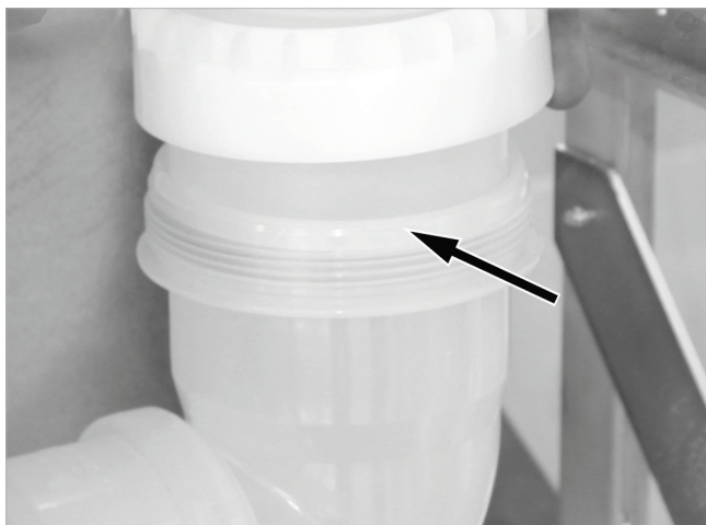
Abb. 42: Abgasbogen gerade ausgerichtet verschrauben
