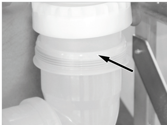
Abb. 66: Abgasbogen gerade ausgerichtet verschrauben
