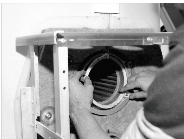
Abb. 52: Brennerdichtschnur einlegen, Stoß oben
