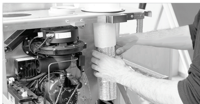
Abb. 62: Innenrohrschalldämpfer einsetzen
