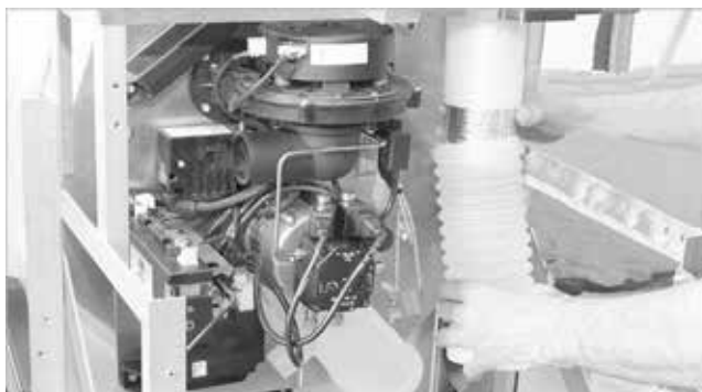
Abb. 63: Abgasanschlusstück aufstecken
