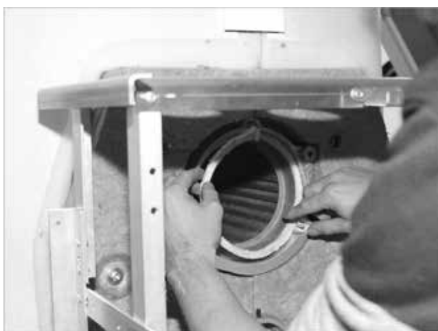
Abb. 52: Brennerdichtschnur einlegen, Stoß oben
