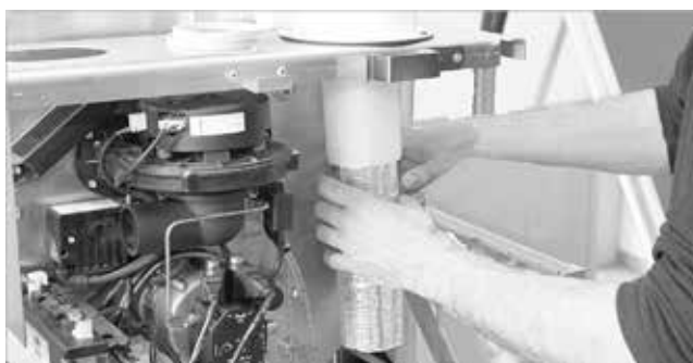
Abb. 62: Innenrohrschalldämpfer einsetzen
