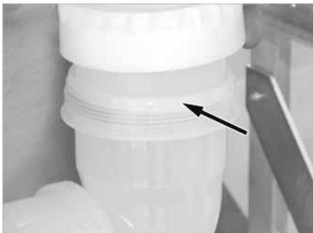
Abb. 42: Abgasbogen gerade ausgerichtet verschrauben
