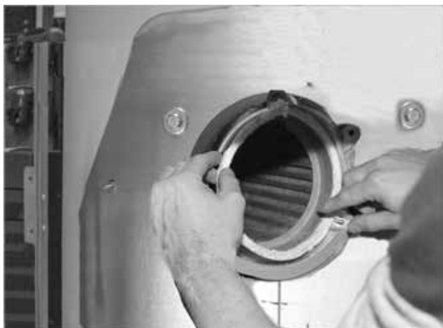
Abb. 29: Brennerdichtschnur einlegen, Stoß oben
