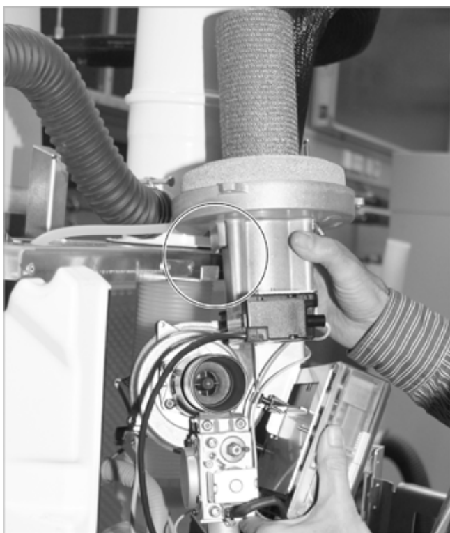
Abb. 113: Brenner in Wartungsposition an der Konsole
