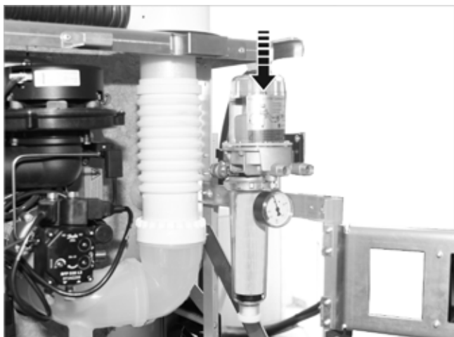
Abb. 68: Ölfilter aufgesteckt
