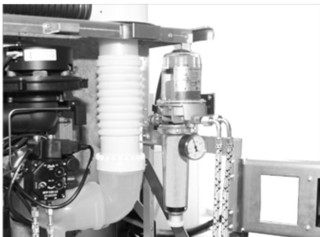
Abb. 69: Ölleitungen anschließen
