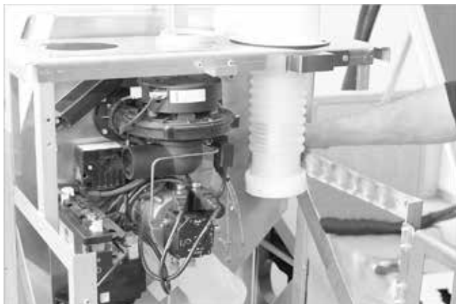
Abb. 64: Abgasanschlussstück gerade ausrichten
