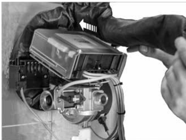
Abb. 32: Mulde am Brennerflansch ausstopfen
