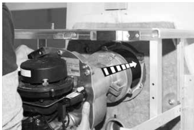
Abb. 58: Brenner einbauen
