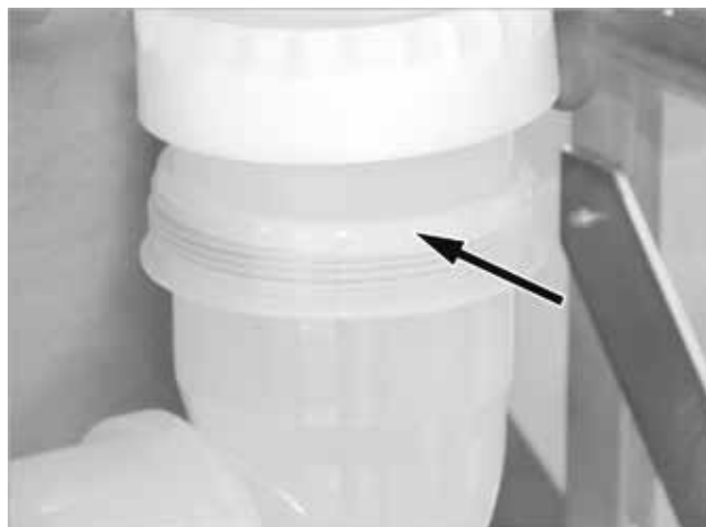
Abb. 66: Abgasbogen gerade ausgerichtet verschrauben
