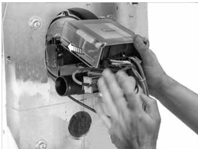
Abb. 31: Brenner einbauen
