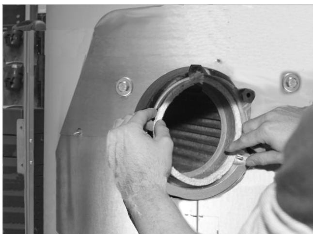
Afb. 6: Branderpakkingssnoer plaatsen, kopse kanten boven
