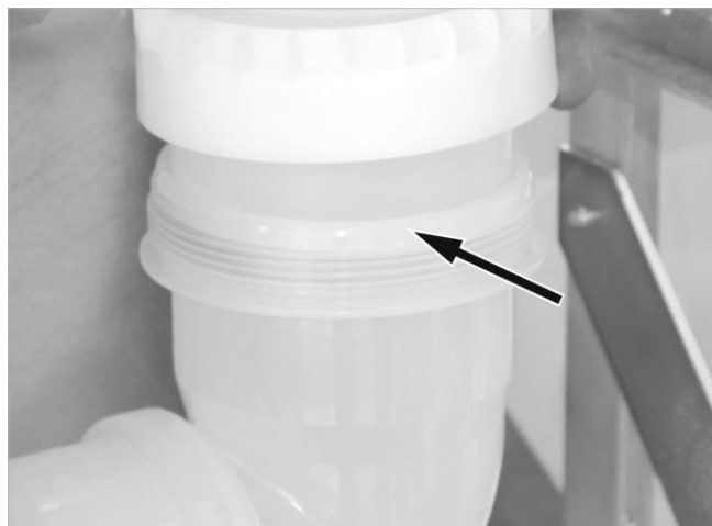
Afb. 19: De rookgasbocht recht uitgelijnd vastschroeven
