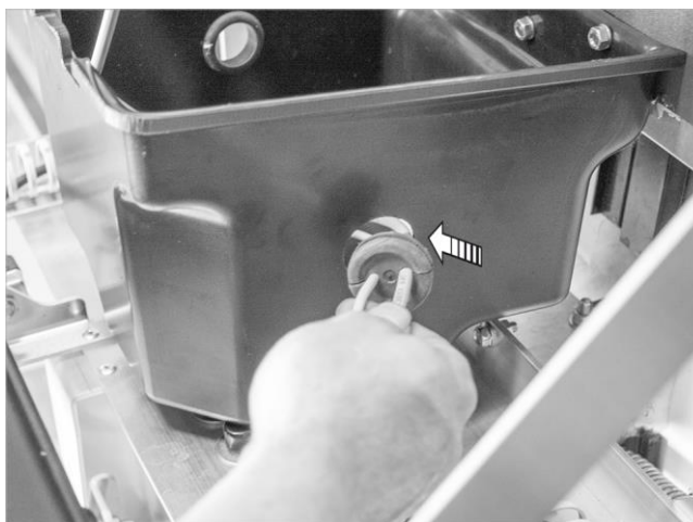
Afb. 12: Branderkabel luchtdicht doorvoeren
