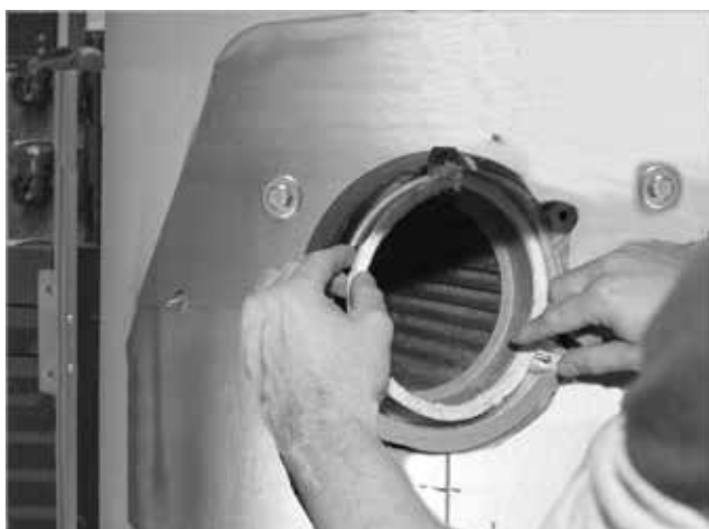
Afb. 6: Branderpakingsnoer plaatsen, kopse kanten boven
