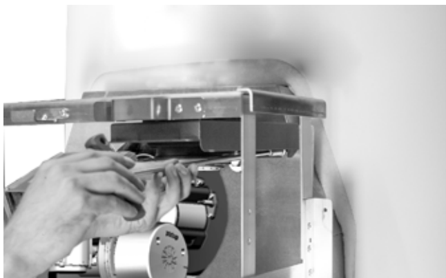
Afb. 14: Houder balgafdichting vastschroeven
