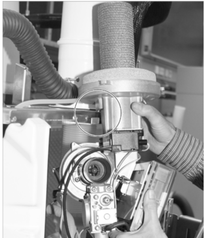
Afb. 31: Brander in onderhoudspositie aan de console
