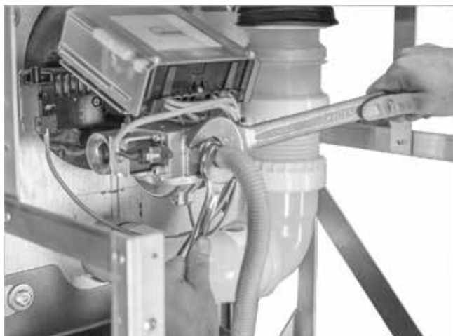
Afb. 23: Gasleiding aansluiten
