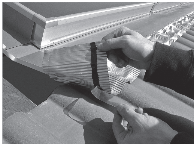
Afb. 48: Beschermingsfolie wegtrekken en loodslabben aandrukken.
