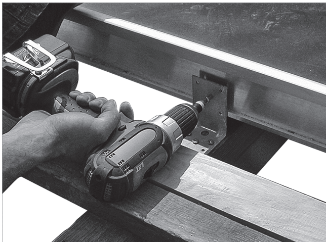
Afb. 50: Aan de bovenste kopse kant de collector op de dakspaar bevestigen
