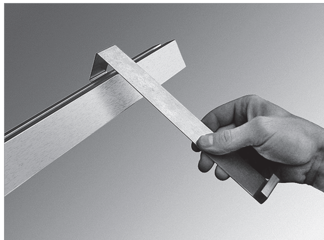
Afb. 20: De valbeveiligingen ophangen (2 per collector)
