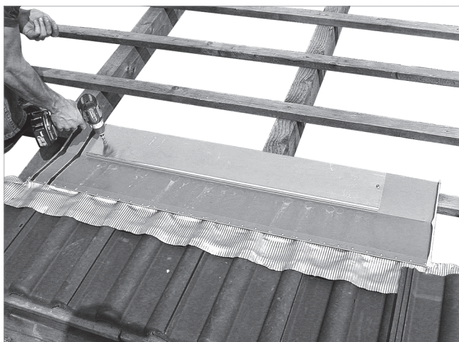
Afb. 46: Aan de rechter zijde de eerste plaat plaatsen en vastschroeven.
