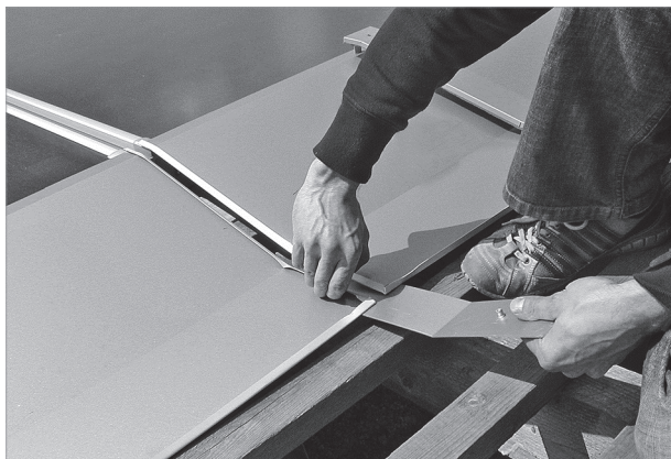
Afb. 80: De onderste plaat van de verbinder onder de bovenplaten schuiven
