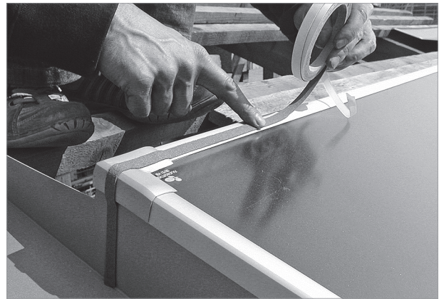
Afb. 68: Voegenafdichtband over de gehele breedte van de bovenste rand plakken
