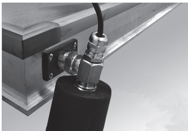
Afb. 91: Sensor monteren (aanvoerleiding van het zonne-energiesysteem)
