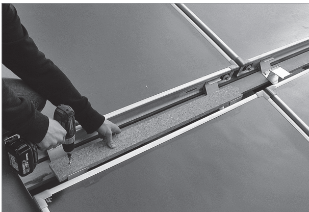
Afb. 67: De tussenplaatsteunen op de collector-afstandsstukken schroeven
