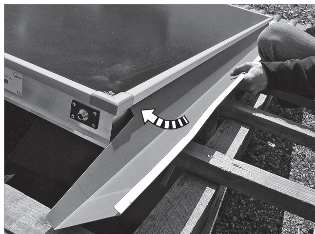
Afb. 55: De plaat op de sleuf onder het onderste klemprofiel plaatsen en dan tegen de collector aan schuiven
