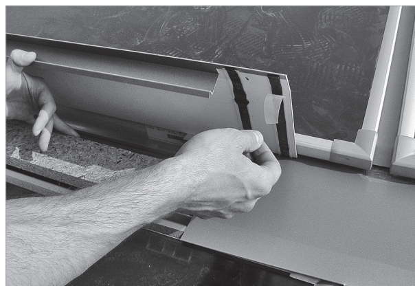
Afb. 74: Overige platen monteren: Voor het plaatsen beschermfolie wegtrekken
