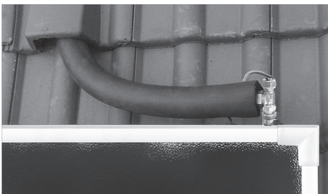
Afb. 93: De aanvoerleiding aansluiten
