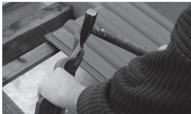
Afb. 86: Evt. de neuzen (nokken) verwijderen
