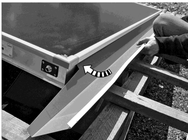
Afb. 63: De plaat op de sleuf onder het onderste klemprofiel plaatsen en dan tegen de collector aan schuiven
