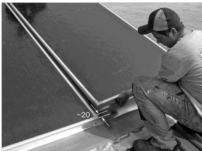
Afb. 53: De volgende collector plaatsen en tegen de borgplaat naar beneden schuiven
