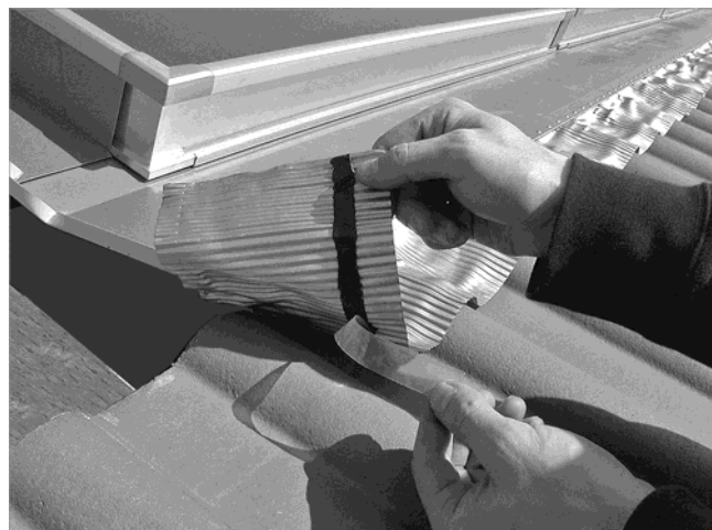
Afb. 48: Beschermingsfolie wegtrekken en loodslabben aandrukken.
