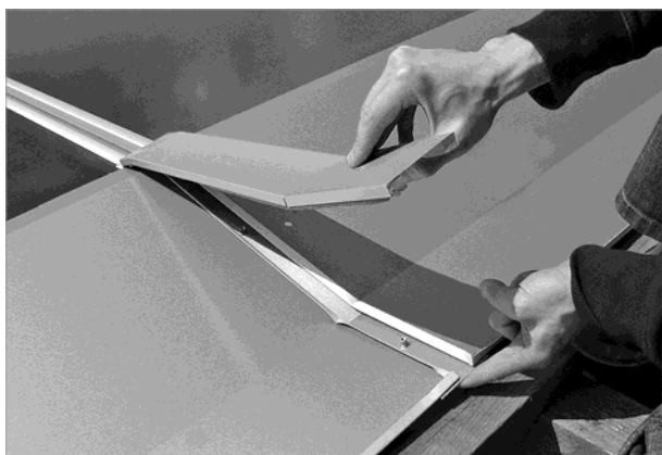
Afb. 81: De bovenste plaat van de koppeling met de onderste in lijn brengen
