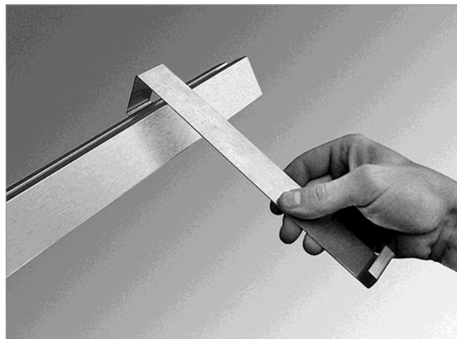
Afb. 20: De valbeveiligingen ophangen (2 per collector)
