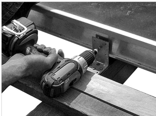
Afb. 50: Aan de bovenste kopse kant de collector op de dakspar bevestigen
