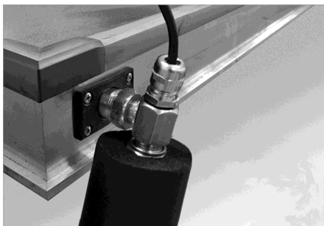
Afb. 91: Sensor monteren (aanvoerleiding van het zonne-energiesysteem)
