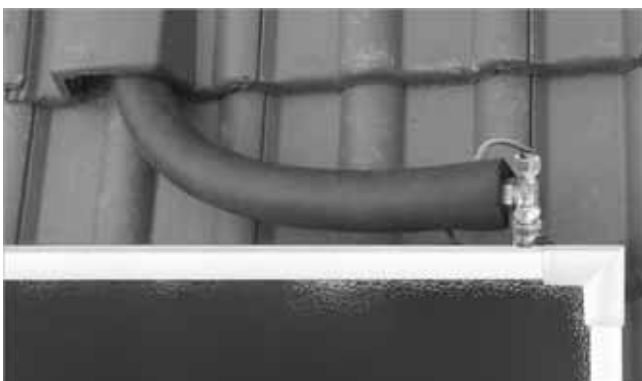
Afb. 93: De aanvoerleiding aansluiten
