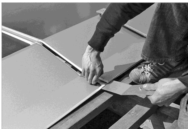
Afb. 80: De onderste plaat van de verbinder onder de bovenplaten schuiven
