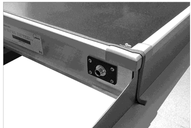
Afb. 78: Over de gehele breedte op de bovenste rand voegenafdichtband plakken
