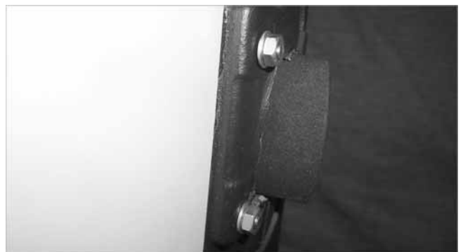
Abb. 7: Muttern festziehen
