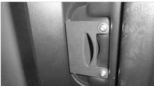
Abb. 6: Schrauben einsetzen
