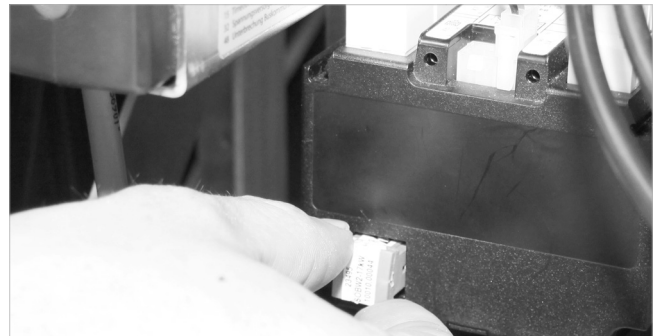
Abb. 8: Brenner-Chipkarte tauschen
