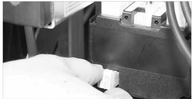
Abb. 8: Brenner-Chipkarte tauschen
