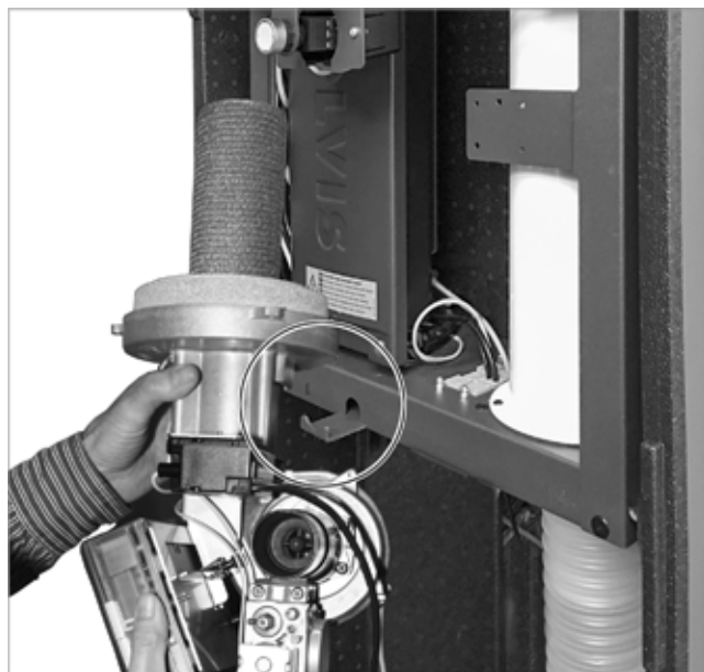
Abb. 141: Brenner an Konsole einhängen (Wartungsposition)
