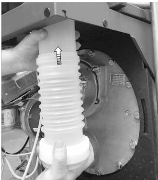
Abb.88: Abgasanschlusstück auf Abgasrohr stecken.
