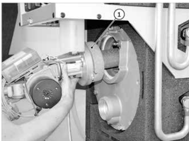
Abb. 49: Brenner einbauen
