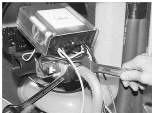
Abb. 60: Gasleitung anschließen
