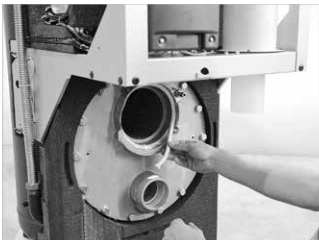
Abb. 46: Brennerdichtschnur einlegen
