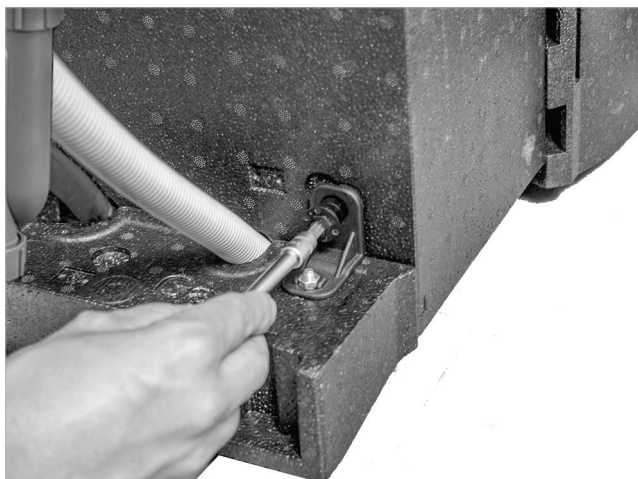
Abb. 96: Winkel befestigen
