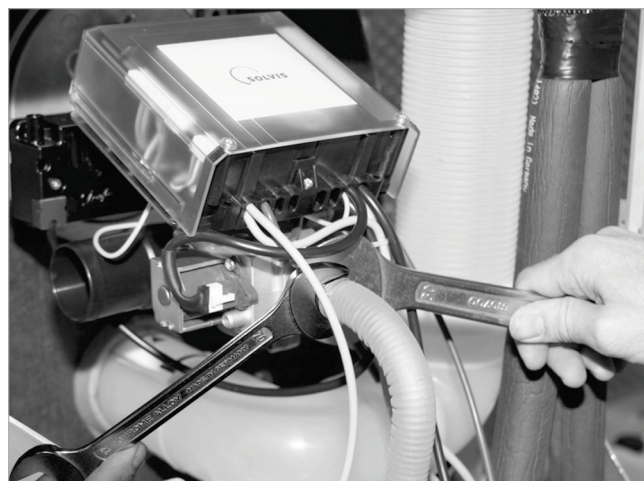
Abb. 60: Gasleitung anschließen
