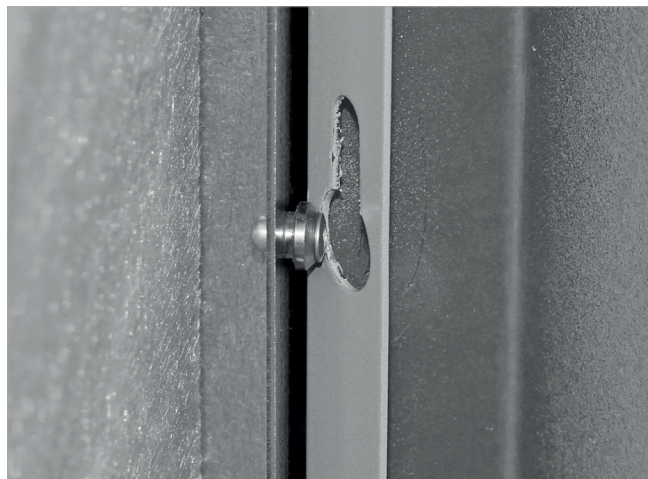
Abb. 86: Bajonettverschluss
