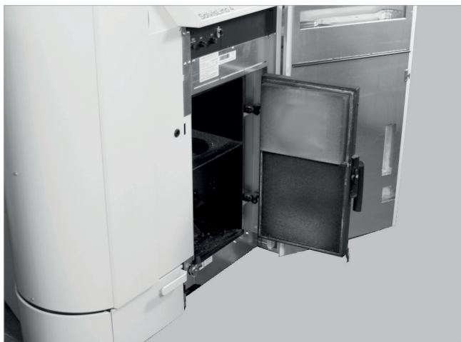
Abb. 140: Brennraumtür öffnen
