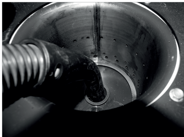
Abb. 152: Primärluftrohr aussaugen
