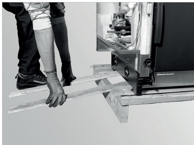
Abb. 7: Verschlagbretter an Rampe legen
