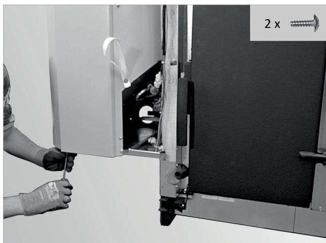
Abb. 39: Blende befestigen
