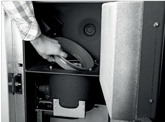
Abb. 144: Konus Oberteil herausheben
