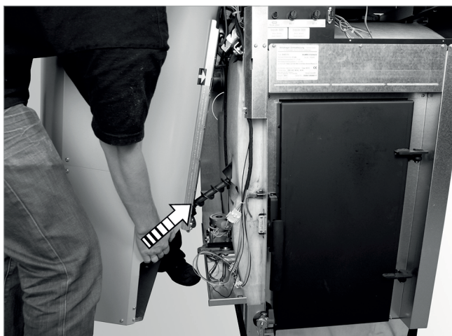
Abb. 28: Förderschnecke einfädeln
