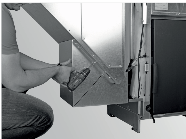
Abb. 60: Sechs Stück Schrauben lockern, Abdeckung abnehmen
