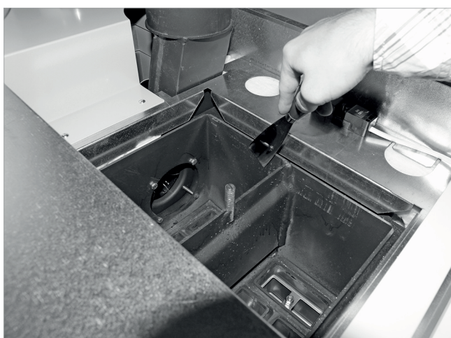
Abb. 160: Nachheizflächen reinigen
