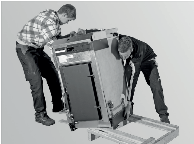
Abb. 9: Kessel von Palette schieben
