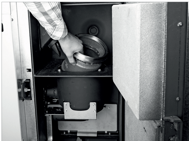
Abb. 145: Konus Unterteil herausheben
