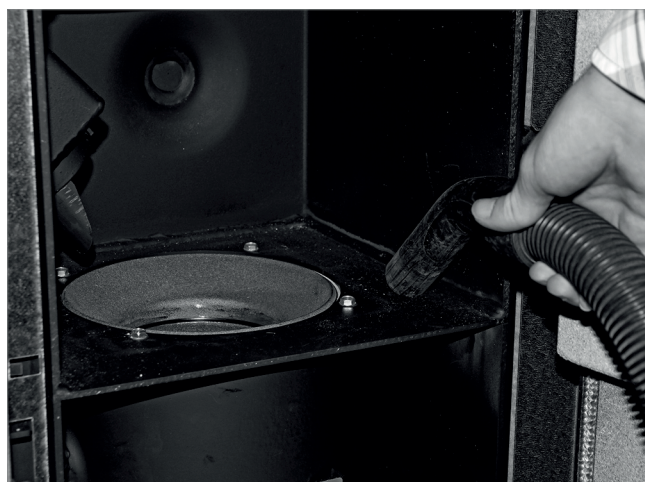
Abb. 143: Verbrennungsrückstände entfernen
