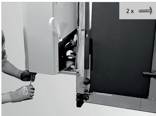
Abb. 169: Schrauben unten entfernen
