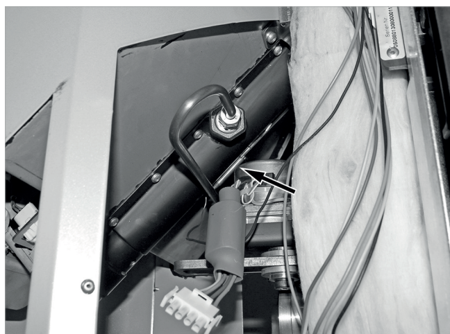
Abb. 34: Sensor einschieben
