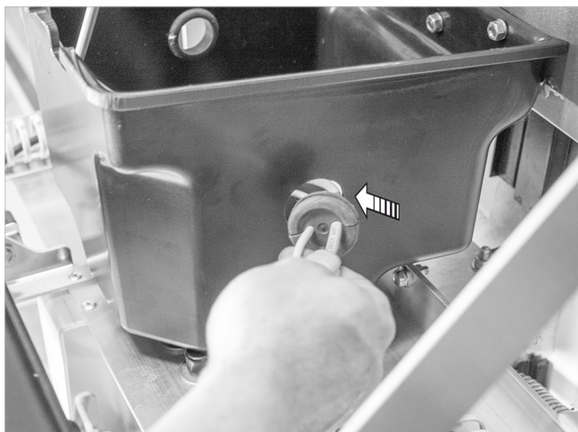
Abb. 36: Brennerkabel luftdicht durchleiten
