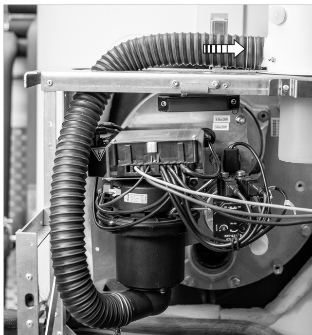
Abb. 60: Zuluftschlauch montieren
