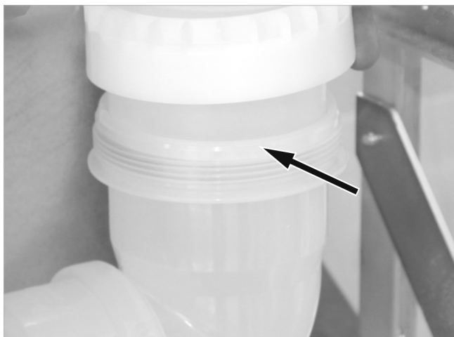
Abb. 43: Abgasbogen gerade ausgerichtet verschrauben
