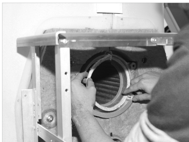
Abb. 53: Brennerdichtschnur einlegen, Stoß oben
