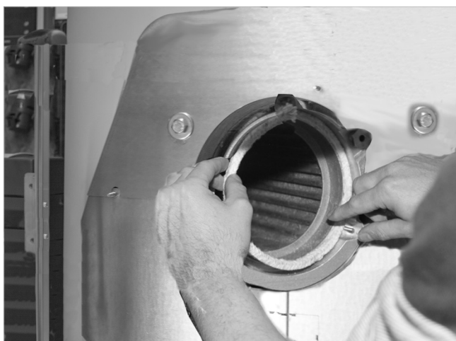
Abb. 30: Brennerdichtschnur einlegen, Stoß oben
