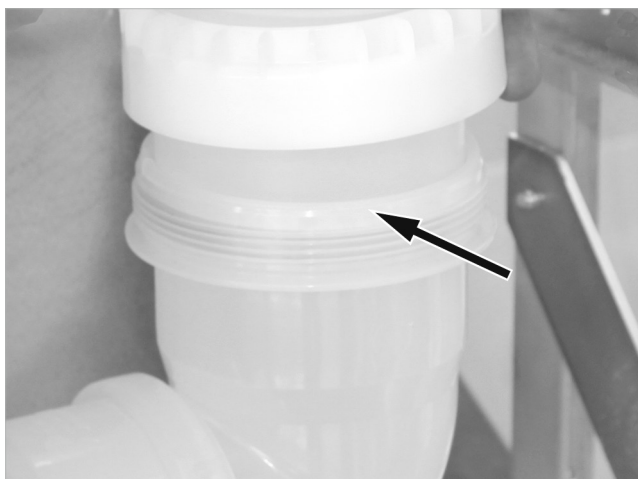
Abb. 66: Abgasbogen gerade ausgerichtet verschrauben
