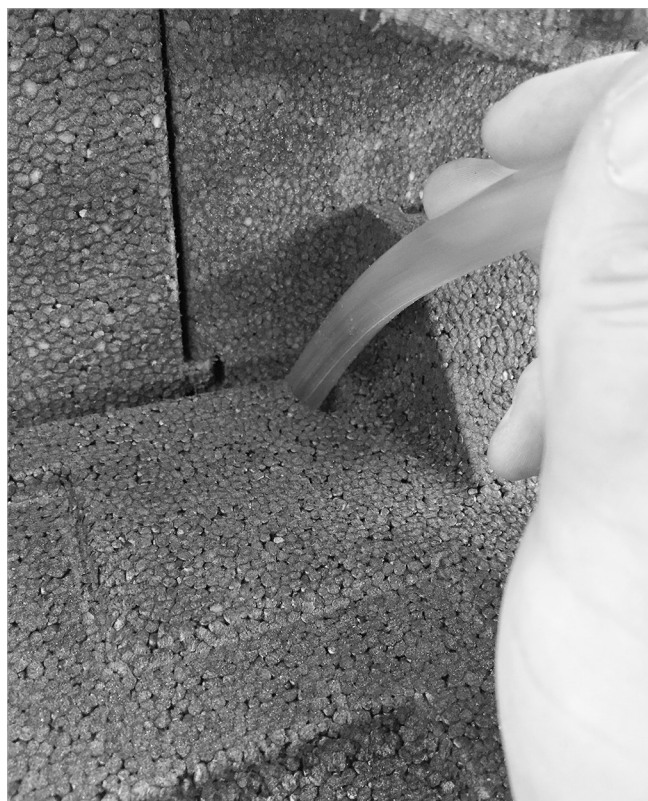
Abb. 7: Druckschlauch durchstecken
