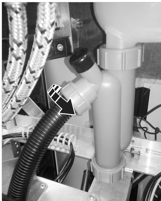
Abb. 25: Kondensatschlauch anbringen (SolvisMax)
