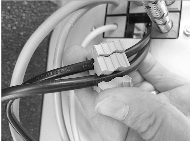
Abb. 14: Kabeldurchführung um Kabel legen
