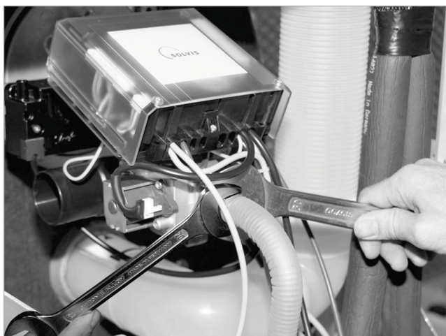
Afb. 60: Gasleiding aansluiten
