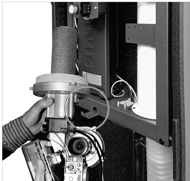
Afb. 141: Brander aan de console hangen (onderhoudspositie)
