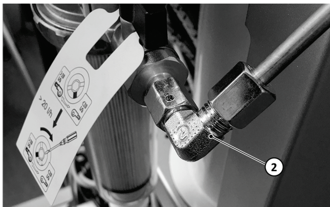
Afb. 82: Olietoevoerleiding op filter aansluiten
