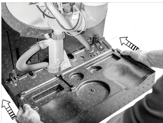
Afb. 97: Voorste vloerdeel monteren
