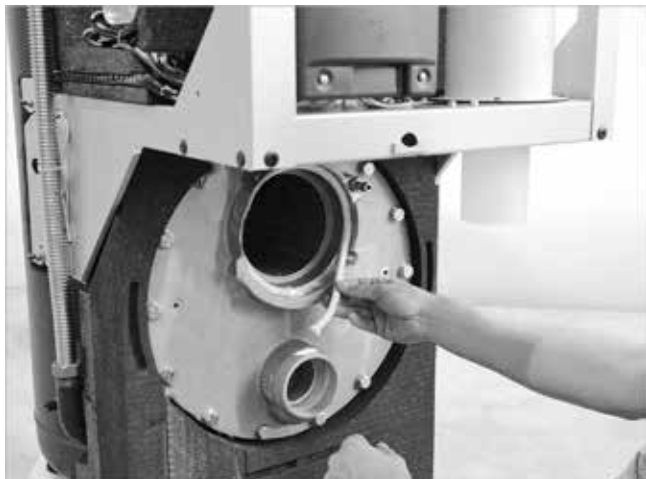
Afb. 64: Branderpakkingsnoer aanbrengen
