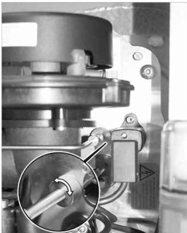
Afb. 151: Kartelmoer (aansluiting olieleiding/sproeierblok)
