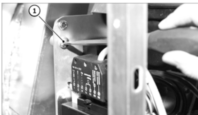
Afb. 144: Snelsluitbouten op het branderinzetstuk
