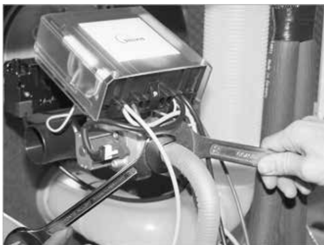
Afb. 60: Gasleiding aansluiten
