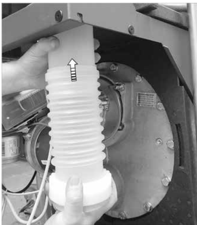
Afb.88: Het aansluitstuk voor rookgas op de rookgaspijp steken.
