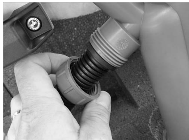
Afb. 5: De condensslang aanbrengen (SolvisBen)
