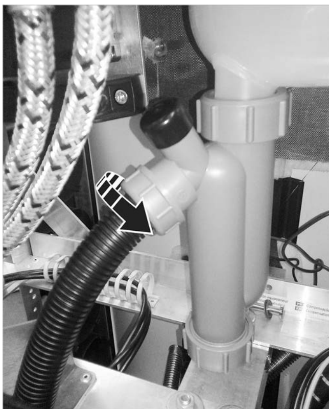
Afb. 17: De condensslang aanbrengen (SolvisMax)
