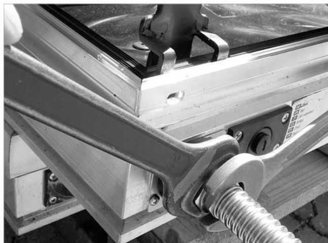
Fig. 9: Fije el tubo ondulado en el exterior.
