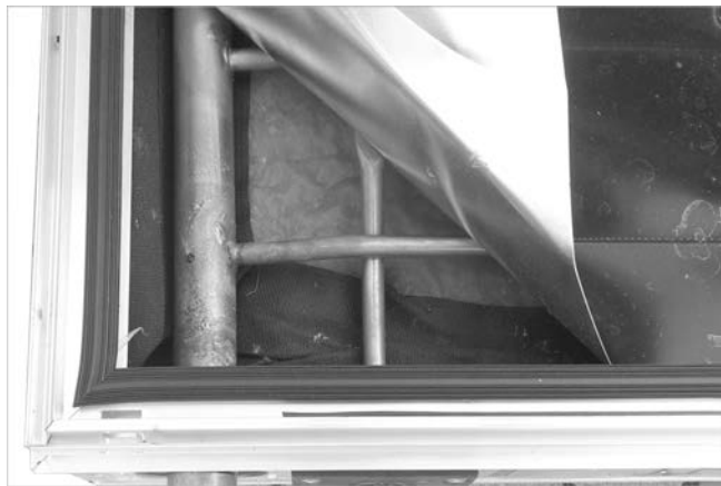
Fig. 4: Pliegue hacia arriba la chapa del absorbedor.
