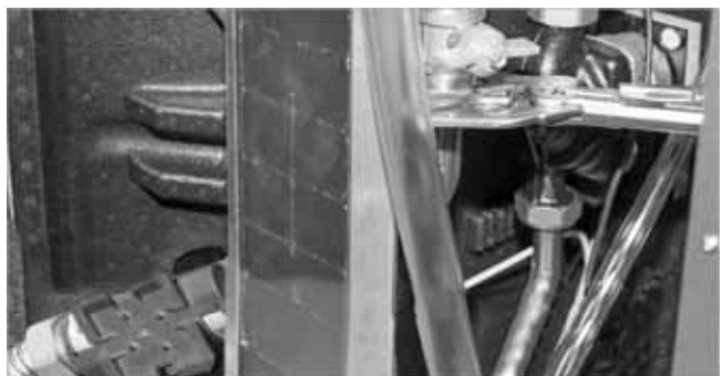
Abb. 9: Rohrbogen einbauen und festziehen
