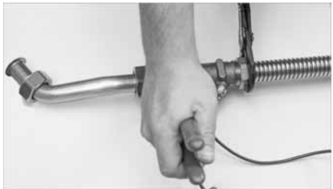
Abb. 8: Wellrohr anschließen und festziehen
