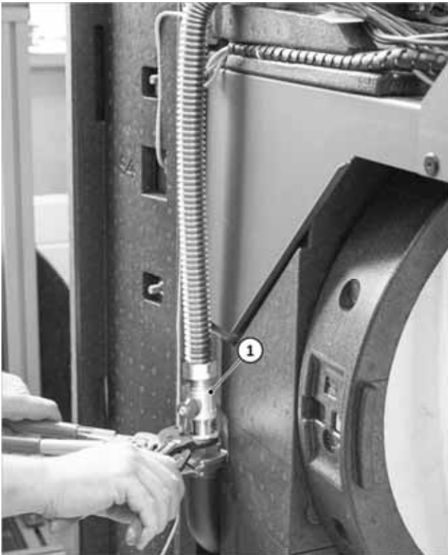
Abb. 10: Wellrohr anschließen, mit optionalem Kugelhahn (1)
