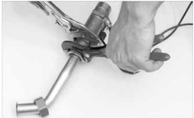
Abb. 7: Rohrbogen und Messstrecke festziehen
