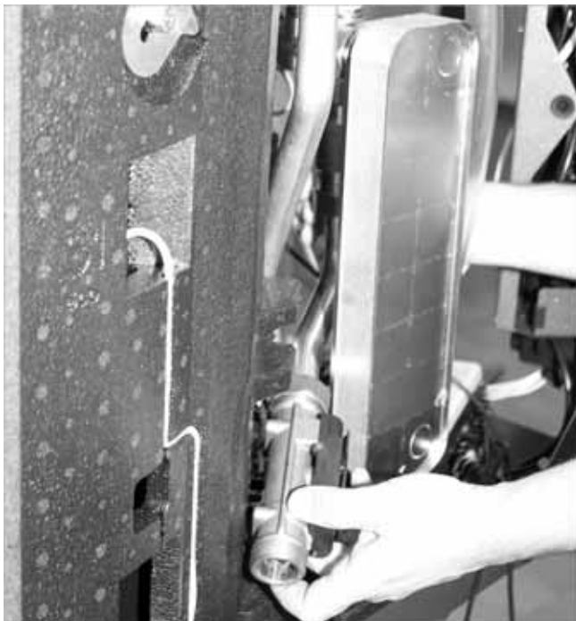
Abb. 6: Rohrbogen und Messstrecke ausrichten
