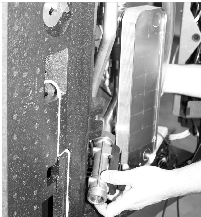
Abb. 6: Rohrbogen und Messstrecke ausrichten
