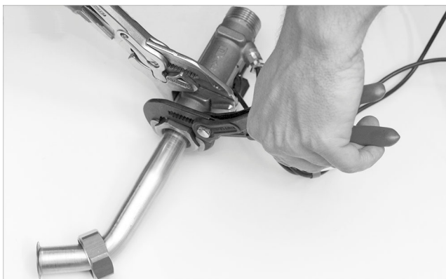
Abb. 7: Rohrbogen und Messstrecke festziehen
