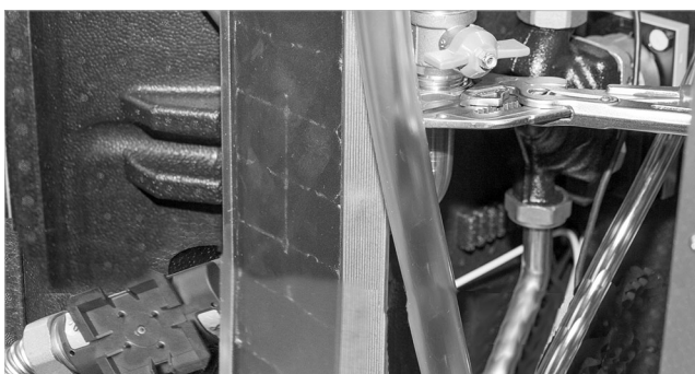
Abb. 9: Rohrbogen einbauen und festziehen
