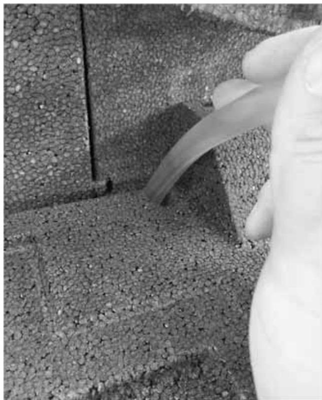
Fig. 8 : faire traverser le tuyau de refoulement
