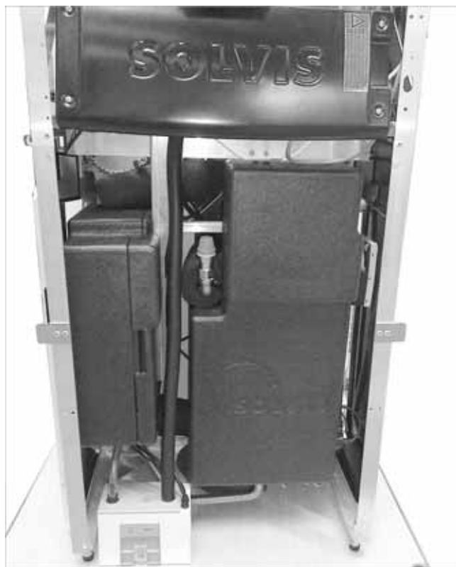
Fig. 15 : installation dans SolvisMax
