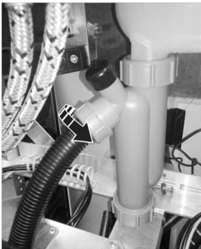
Fig. 17 : placer le tuyau de condensat (SolvisMax)
