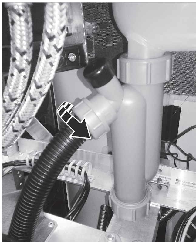
Fig. 17 : placer le tuyau de condensat (SolvisMax)
