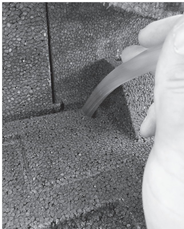
Fig. 8 : faire traverser le tuyau de refoulement
