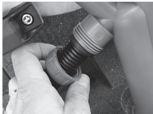
Fig. 5 : monter le tuyau de condensat (SolvisBen)
