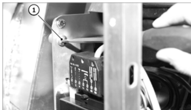
Fig. 144 : vis de fermeture rapide sur le brûleur
