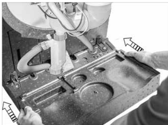
Fig. 97 : encastrement du fond avant
