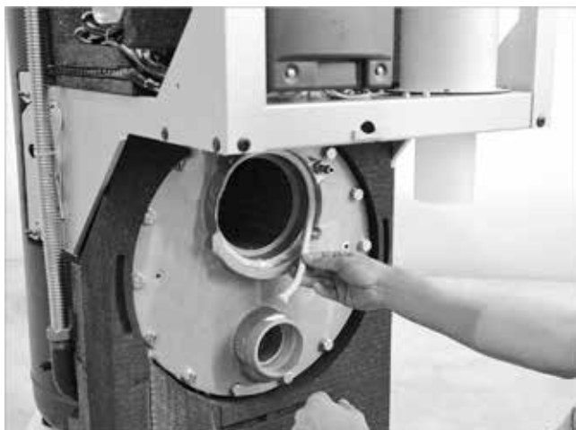
Fig. 64 : installation du cordon d'étanchéité du brûleur
