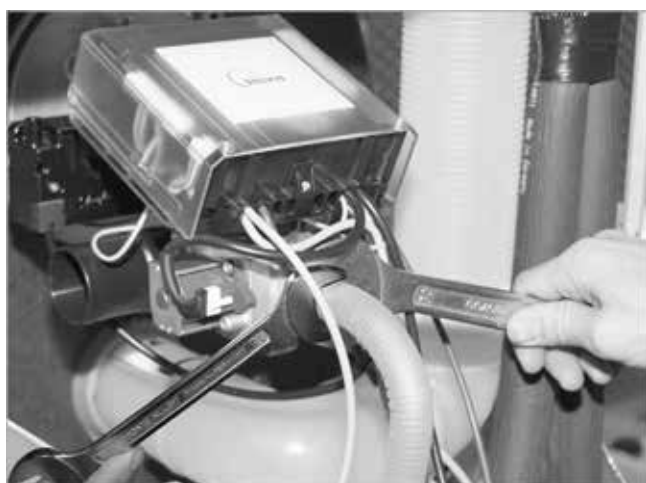
Fig. 60 : Raccordement de la conduite de gaz
