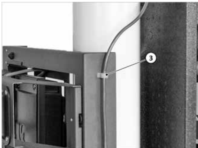
Fig. 83 : fixation de la conduite d'alimentation en fioul sur le châssis
