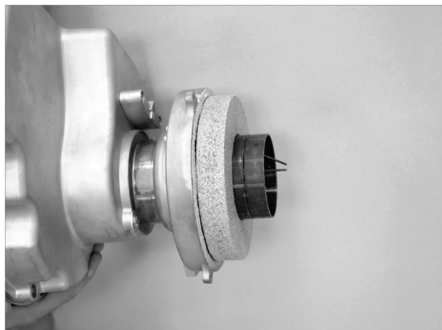
Fig. 68 : pose de la brique réfractaire de porte de chaudière
