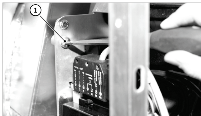
Fig. 144 : vis de fermeture rapide sur le brûleur
