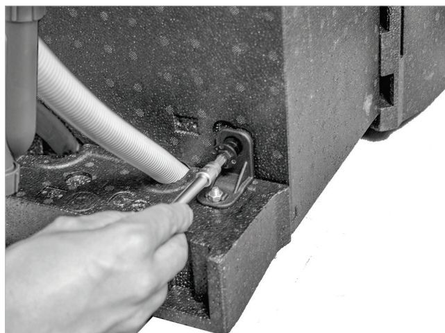
Fig. 96 : fixation de l'équerre
