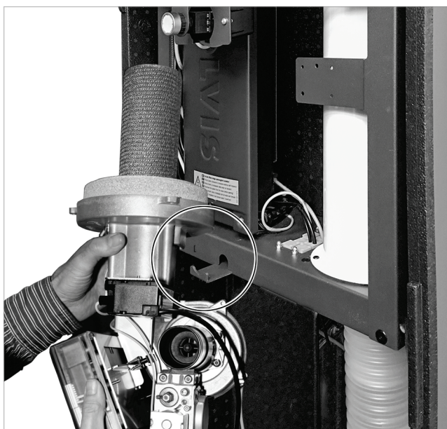
Fig. 141 : accrochez le brûleur sur la console (position de maintenance)
