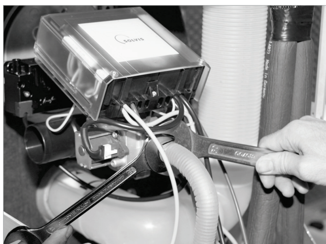
Fig. 60 : Raccordement de la conduite de gaz
