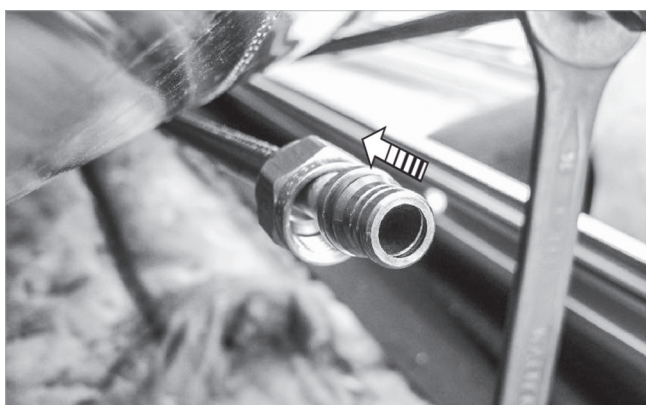
Abb. 8: Rohrenden bestücken
