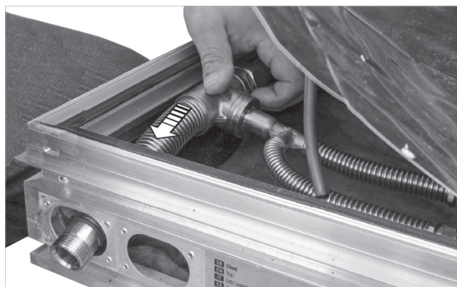
Abb. 10: Wellrohranschluss durchschieben
