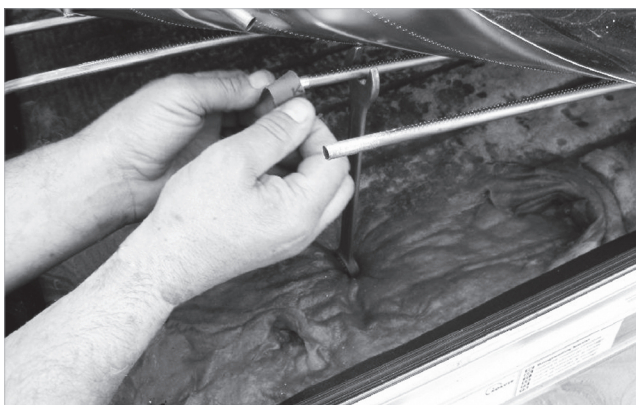
Abb. 6: Rohrenden entgraten und glattschleifen
