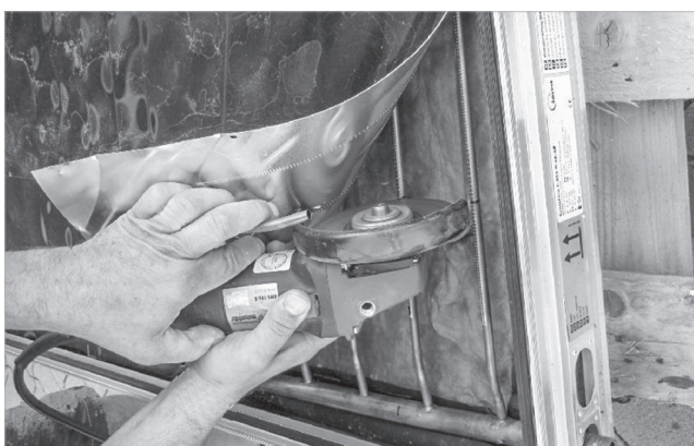
Abb. 5: Wellrohrsegment entfernen
