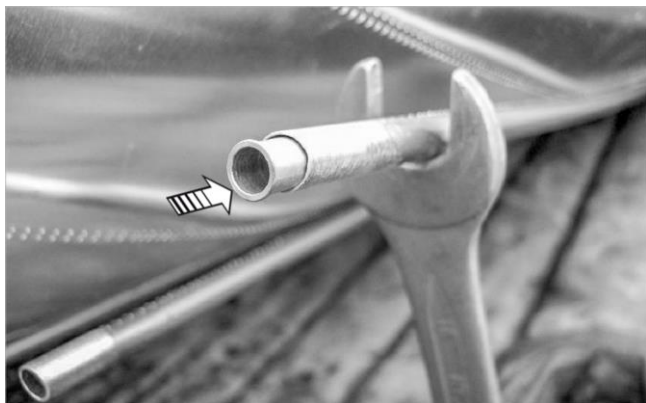
Abb. 7: Stützhülsen einsetzen (hier 8-mm-Rohr)
