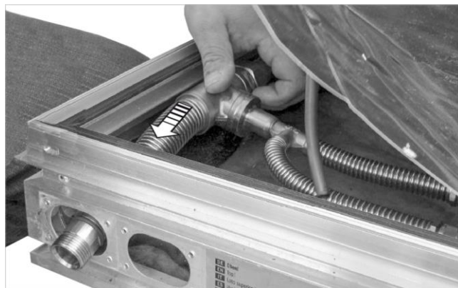
Abb. 10: Wellrohranschluss durchschieben
