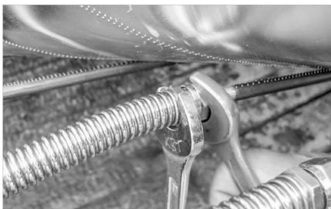
Abb. 9: Klemmringverschraubung festziehen
