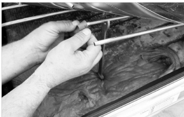
Abb. 6: Rohrenden entgraten und glattschleifen
