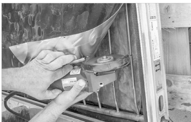
Abb. 5: Wellrohrsegment entfernen
