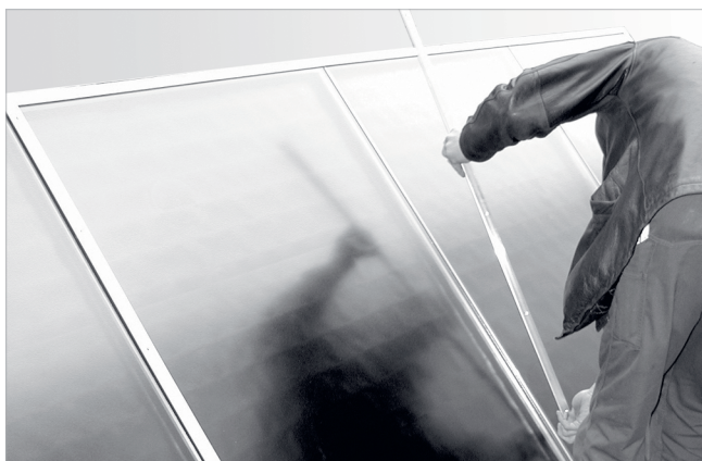
Fig. 37: montaggio dei listelli di copertura della traversa
