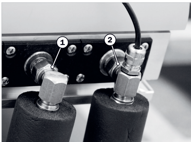
Fig. 71: Sensore immersione montato, SolvisFera Integra
