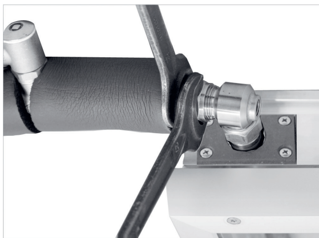
Fig. 57: Attacco in alto: Mandata solare
