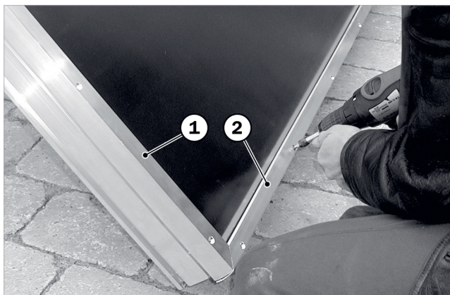
Fig. 34: posizionamento, allineamento e avvvitamento dei profilati a clip
