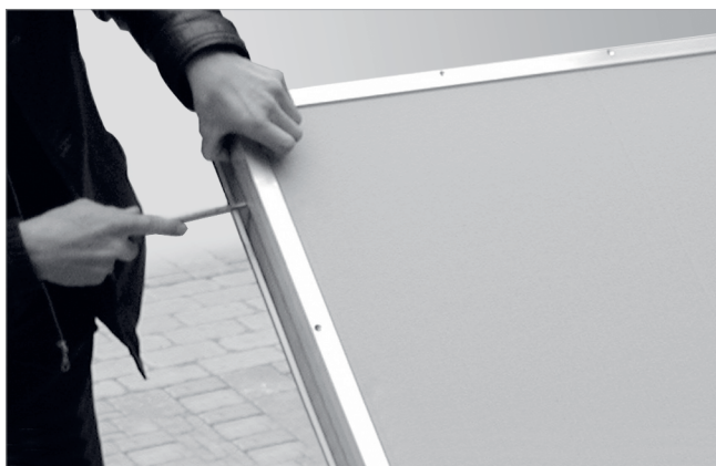
Fig. 32: rimozione dei profilati a clip e dei cartoni di copertura
