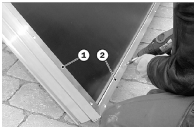
Fig. 34: posizionamento, allineamento e avvitarmento dei profilati a clip
