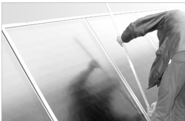
Fig. 37: montaggio dei listelli di copertura della traversa
